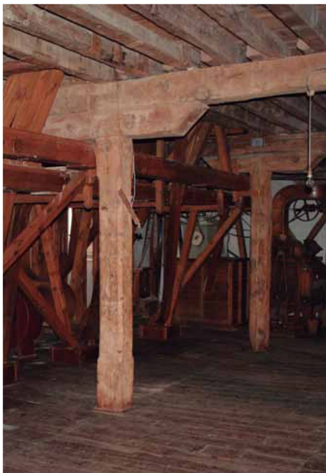
Imagen del interior de la fábrica donde se puede ver el sistema estructural del edificio.
