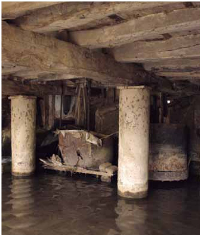
Interior del cárcavo con rodeznos de regolfo de un molino en San Felices de Órbigo, León.
