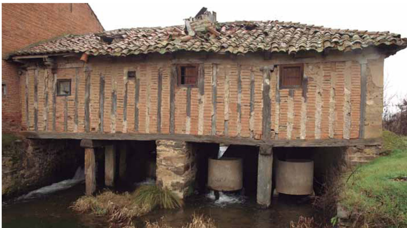
Molino hidráulico en Hospital de Órbigo, León.
