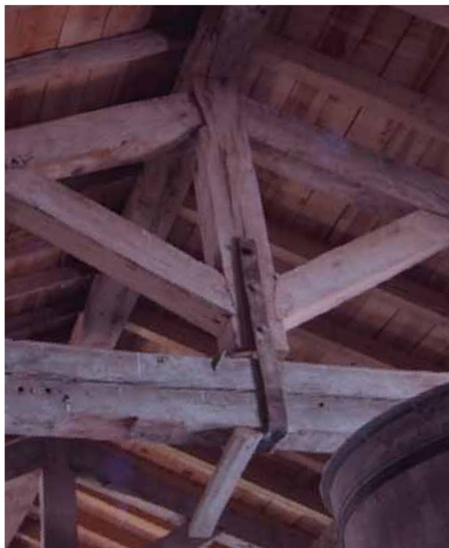
Detalle de la cercha de madera.
