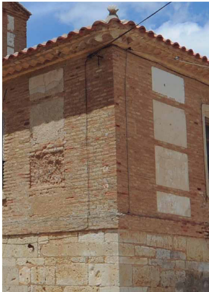
Detalle del cerramiento de la fábrica donde se pueden observar los diferentes sistemas constructivos utilizados.
