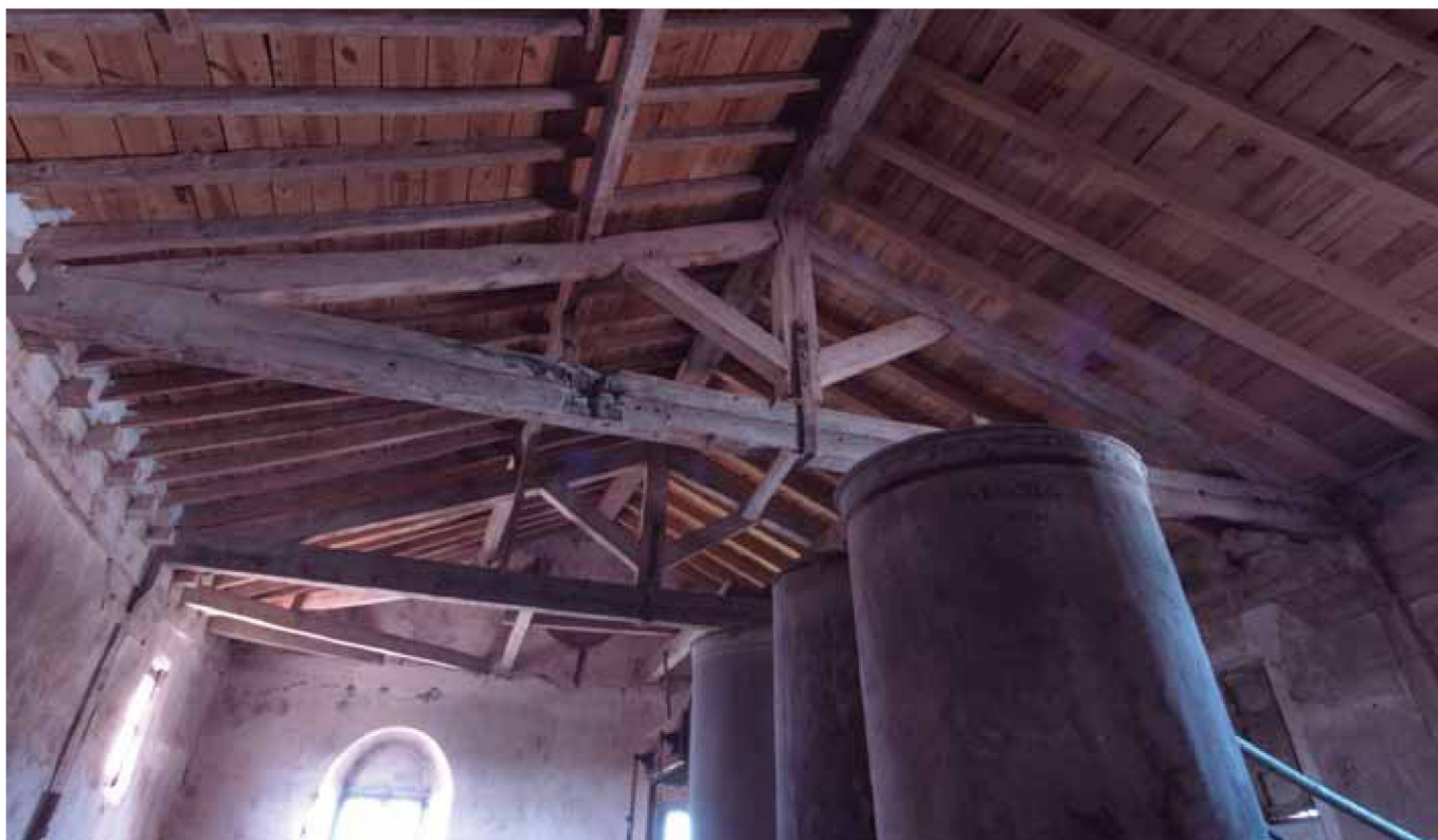
Detalle de la estructura de madera del bajocubierta, constituida por cerchas a la española.
