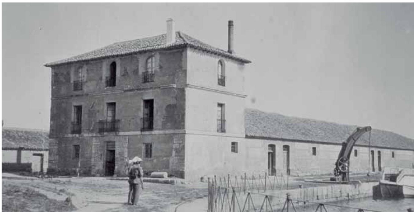
Imagen de la vivienda de los guardas de la dársena en la que se observan también parte de los almacenes y la grúa metálica para la carga y descarga de materiales, década de 1920 [AGCHD, RC-59].
