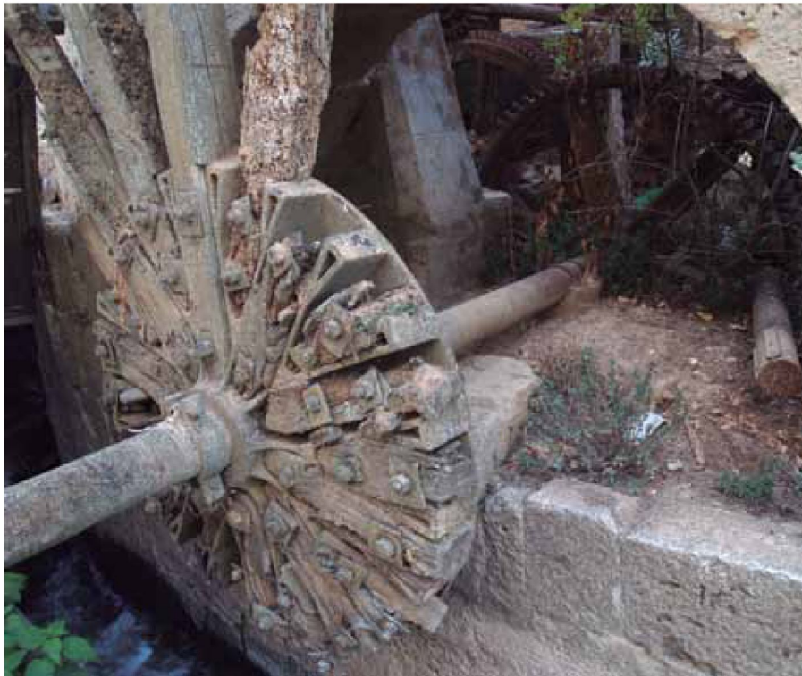
Transmisión de movimiento de la Aceña de Zafraguillas en Tordesillas.
