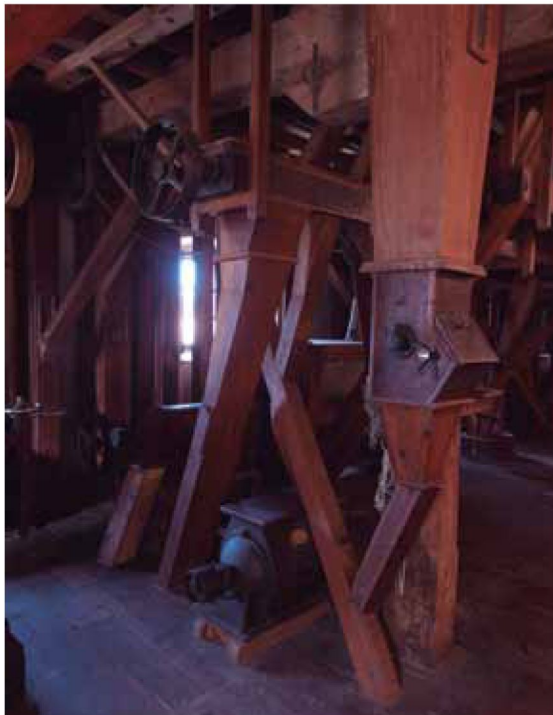
Elevadores y Distribuidores.
