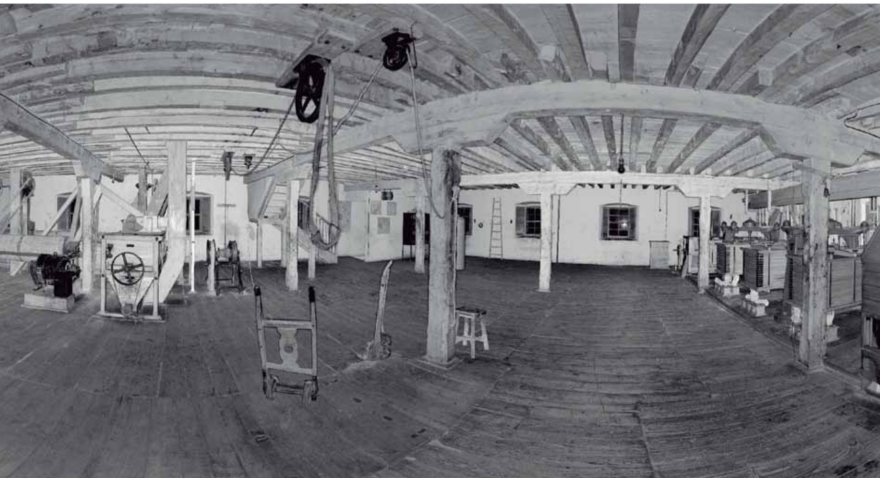
Aspecto de una nube de puntos del interior de la fábrica.
