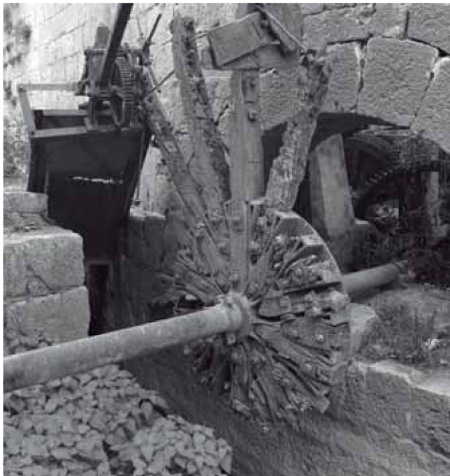
Rueda de palas vertical o "vitruviana" de la aceña de Zafraguillas en Tordesillas, Valladolid.
