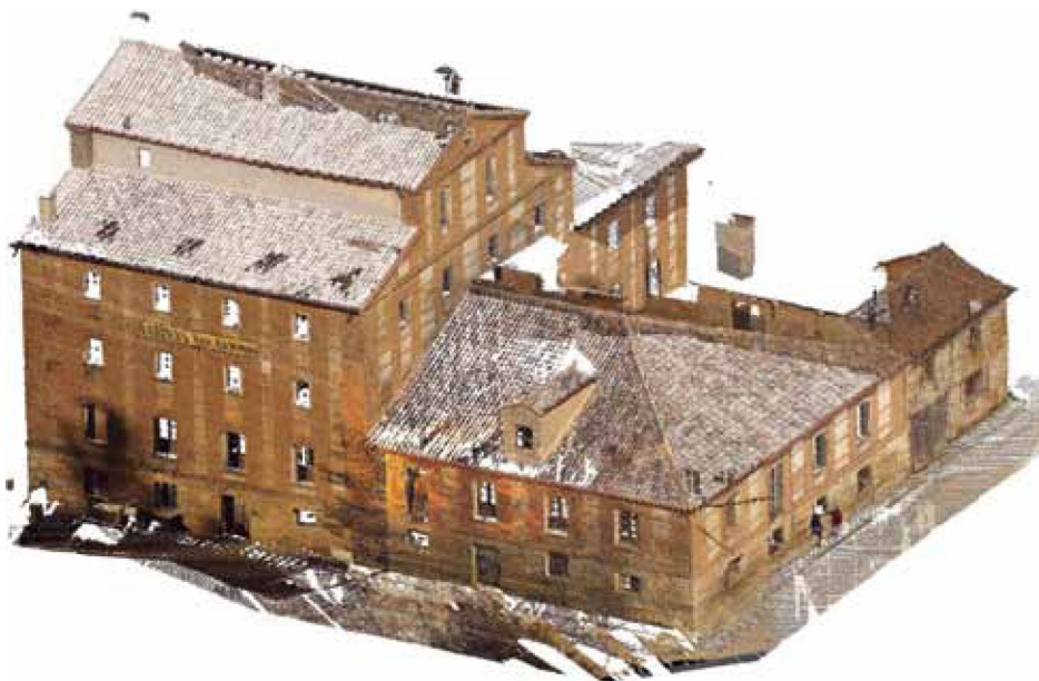
Modelo 3D de puntos a color de la fábrica de harinas, obtenido con el escáner de largo alcance Iiris3D Optech.
