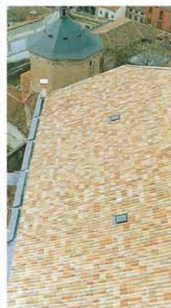
Estado reformado de la cubierta
