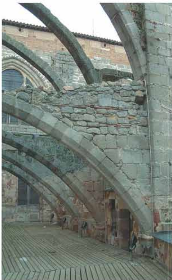
Estado final del adarve
