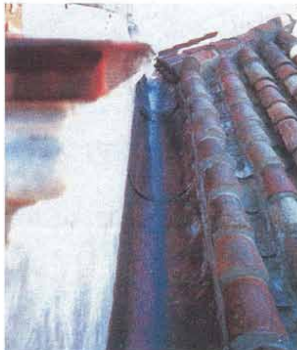
Limahoya entre faldones de teja. Estado reformado
