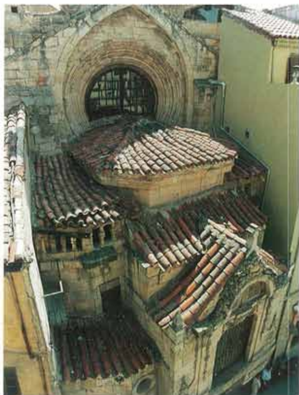
Cubiertas de la capilla antes de la restauración
