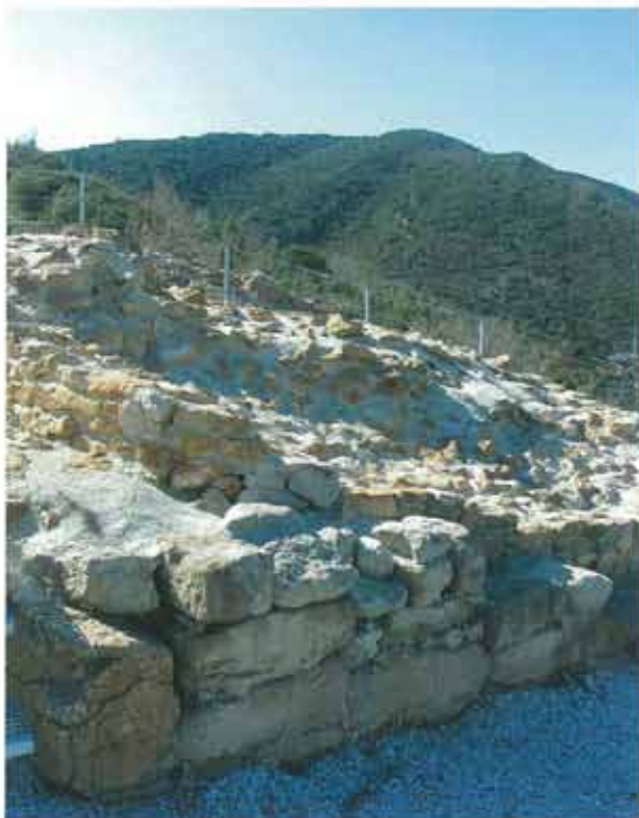
Fortaleza de Tedeja. Muralla. Vallado del yacimiento y escaleras de acceso al torreón
