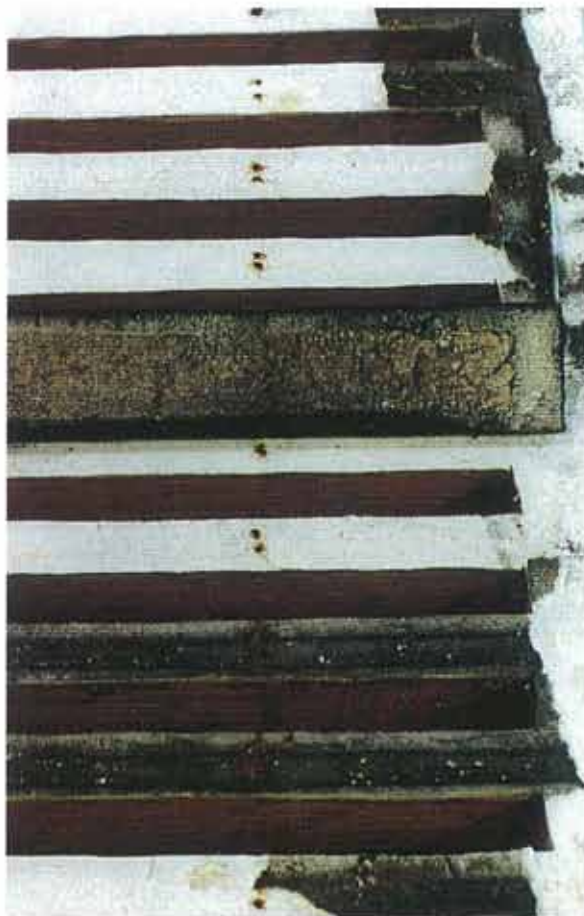
Detalle de las ventillas y sus regatas en el secreto durante el proceso de restauración.
