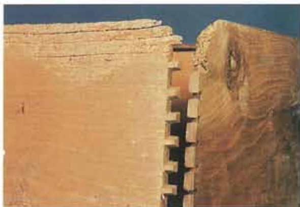
Ensamble de cola de milano de los cajones y presencia de carcoma
