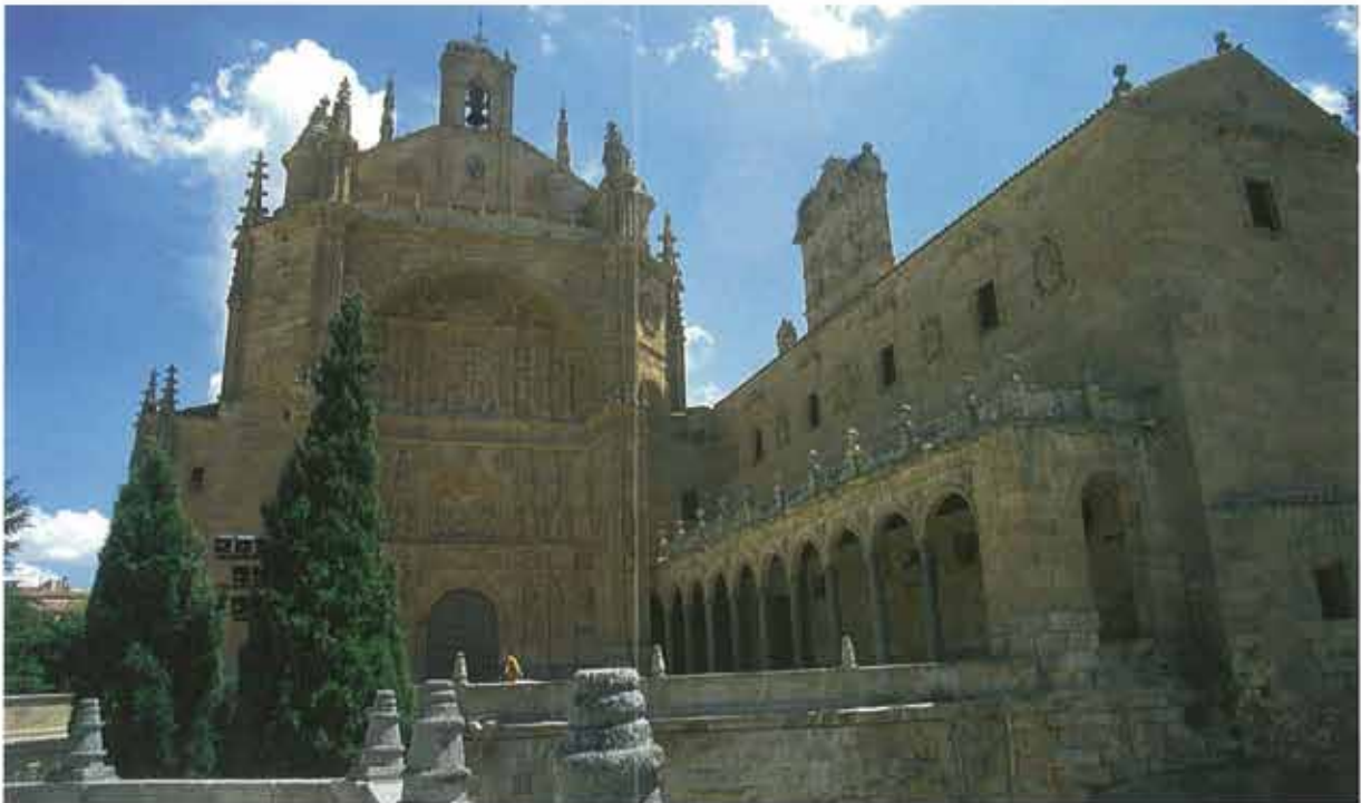
La Iglesia y la Portería desde la calle Arrollo de Sto. Domingo
