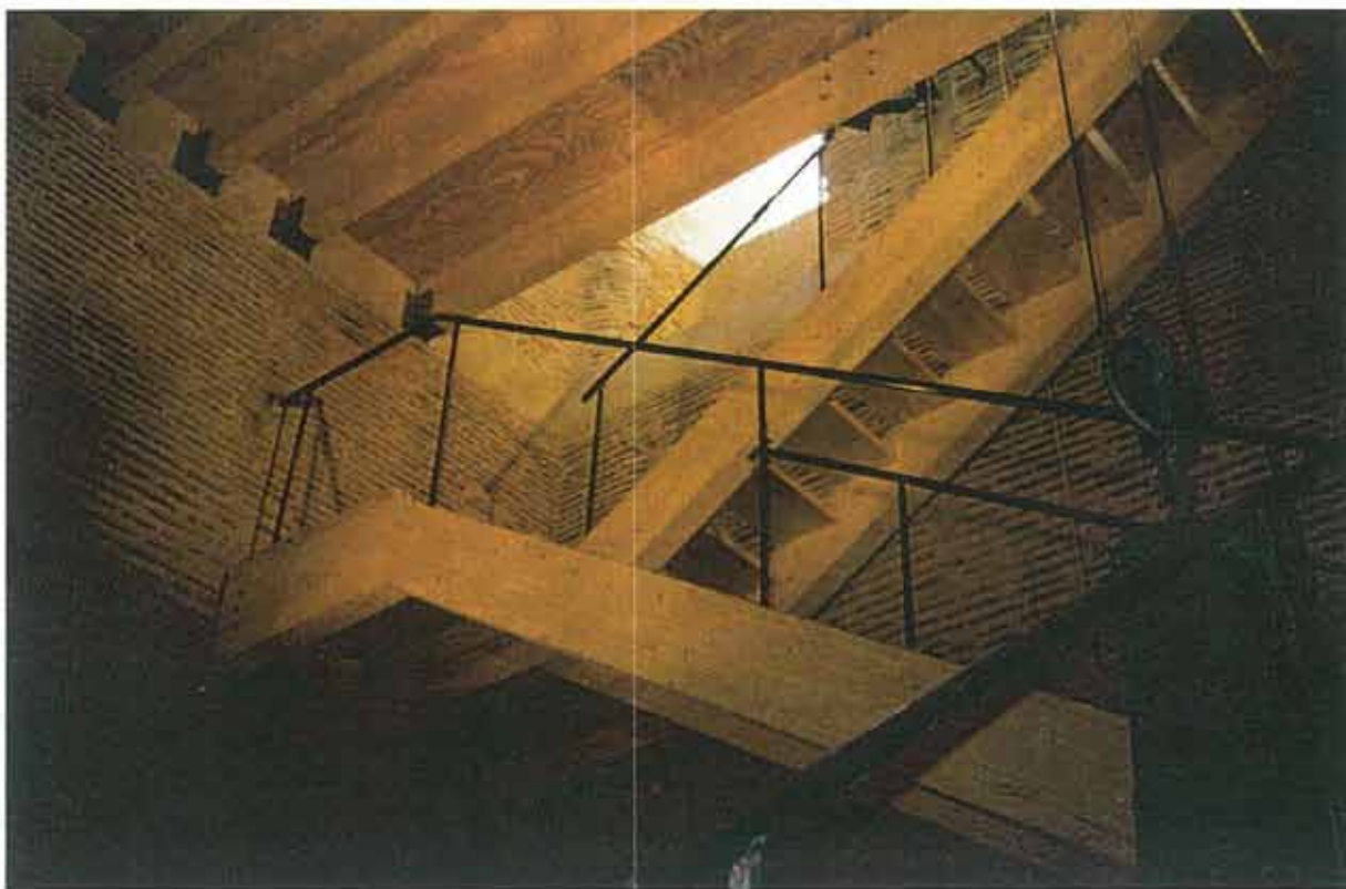
Estado reformado. Escalera de la torre
