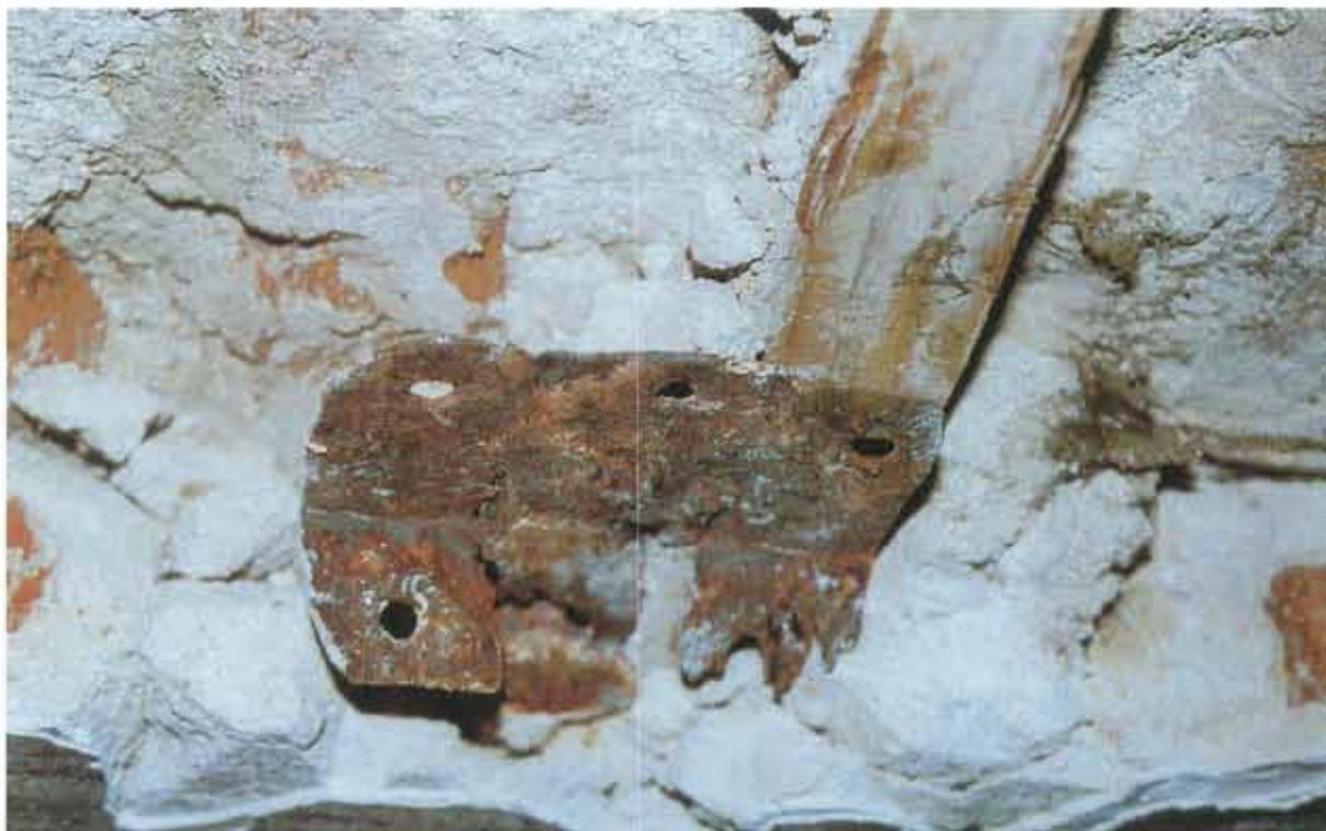
Pieza de hierro con la que se sujetaban los marcos al muro
