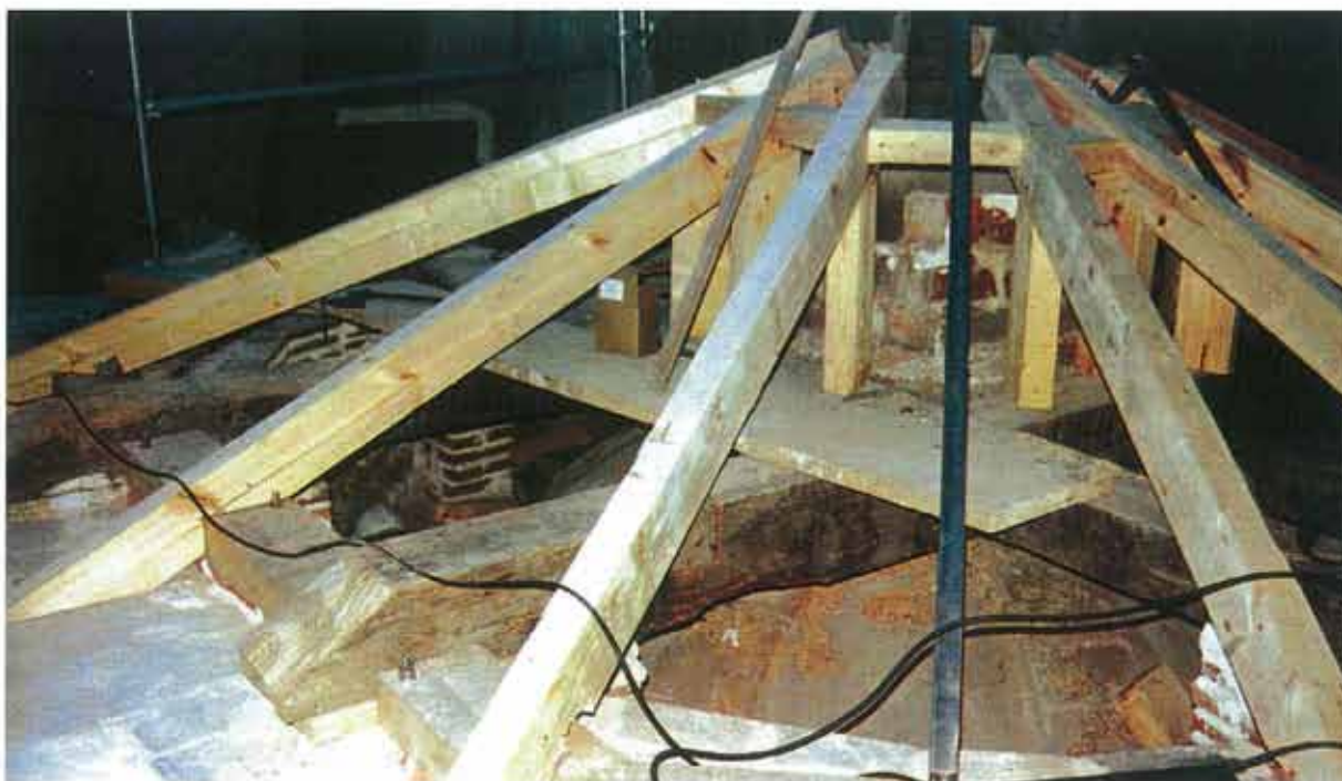
Nueva estructura de la cubierta de la cúpula
