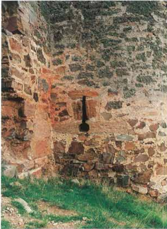
Interior del Castillo. Tronera de la cámara abovedada de la torre Suroeste de la barrera del Castillo
