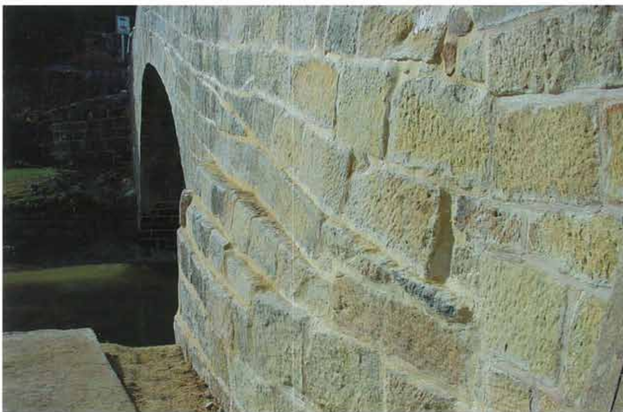
Estado posterior a la intervención
