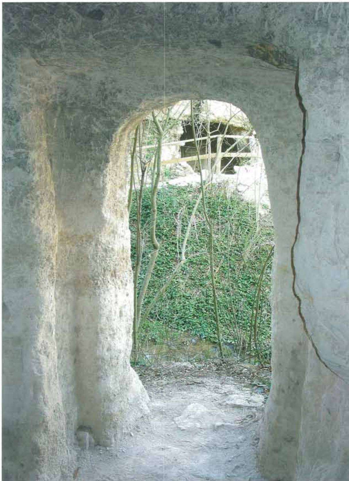
Puerta de acceso excavada en la roca en el lugar de las Cuevas de los Portugueses
