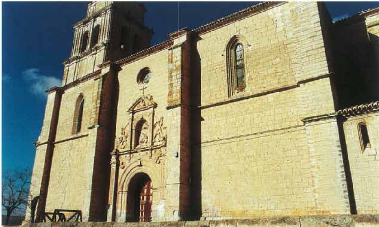
Vista general de la fachada principal de la iglesia, apreciándose la portada y la torre
