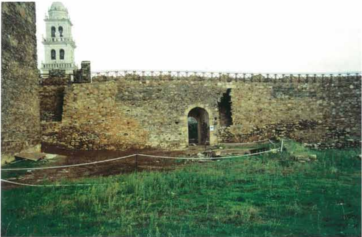
Estado reformado. Vista interior
