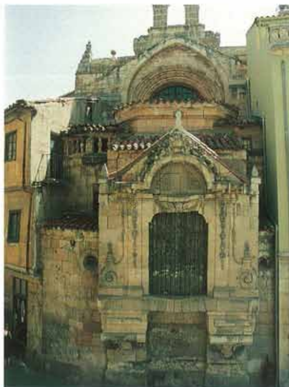
Fachada de la capilla antes de la intervención
