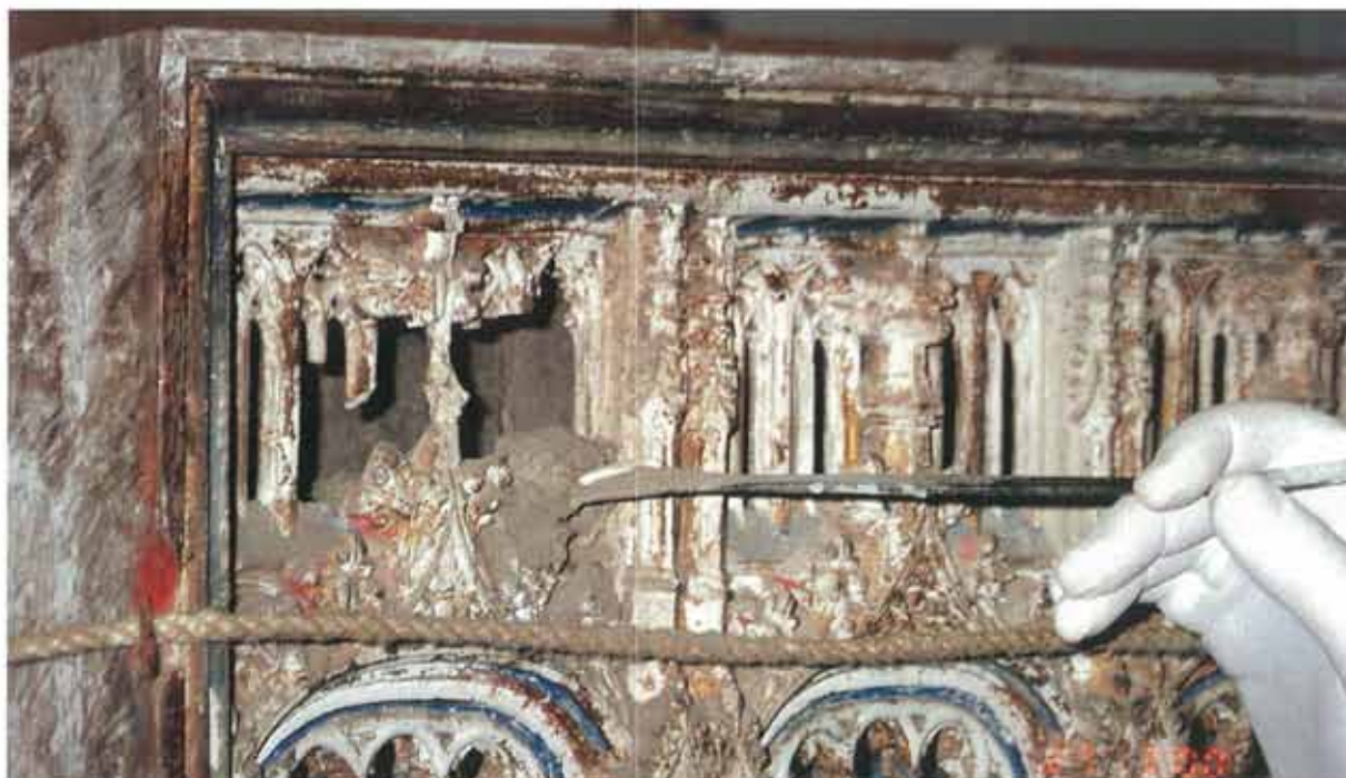
Proceso de limpieza de la crestería. En este proceso se recuperaron varios fragmentos desprendidos
