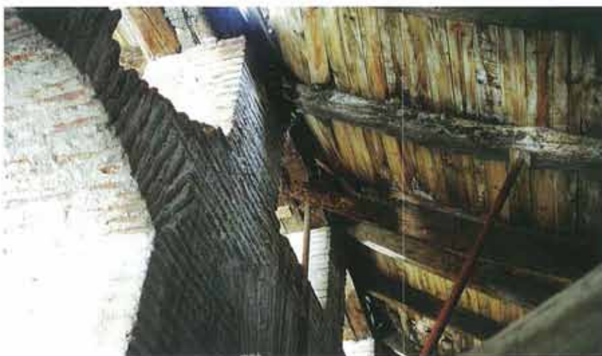
Estado inicial de la estructura de cubierta
