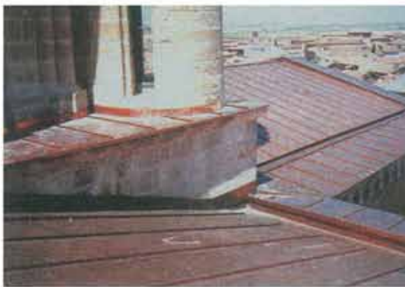
Cubierta de cobre rematada sobre el crucero
