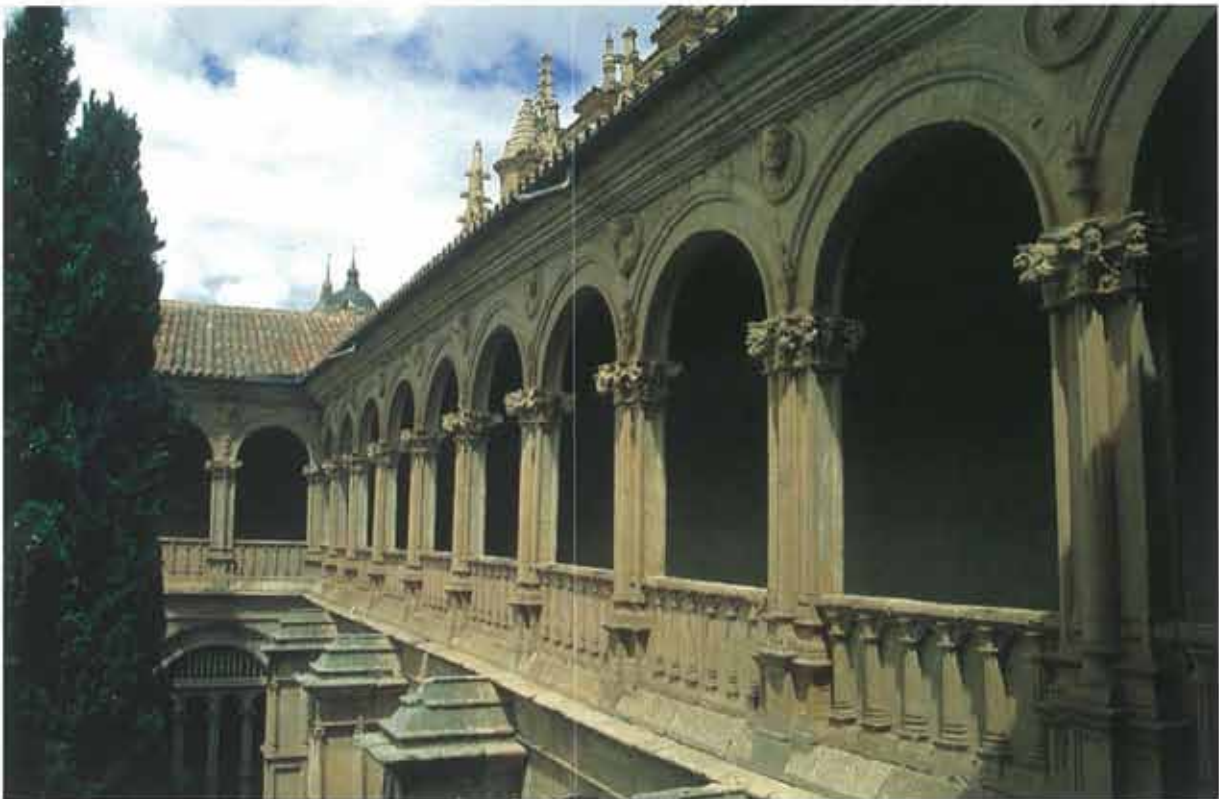
Galería alta del Claustro de los Reyes. Vista genera
