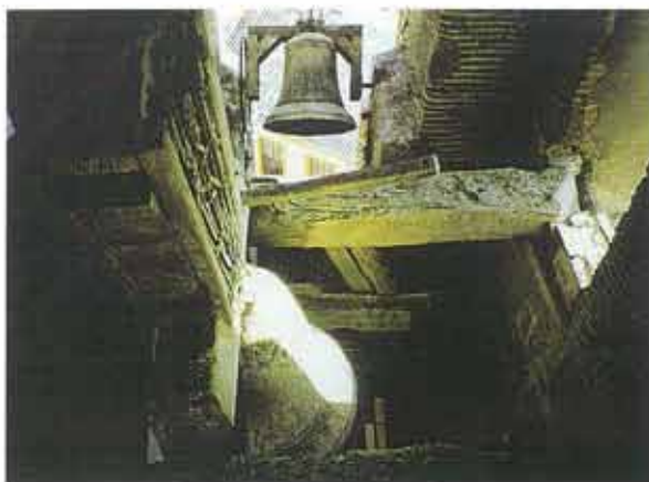
Estado inicial. Estructura de campanas
