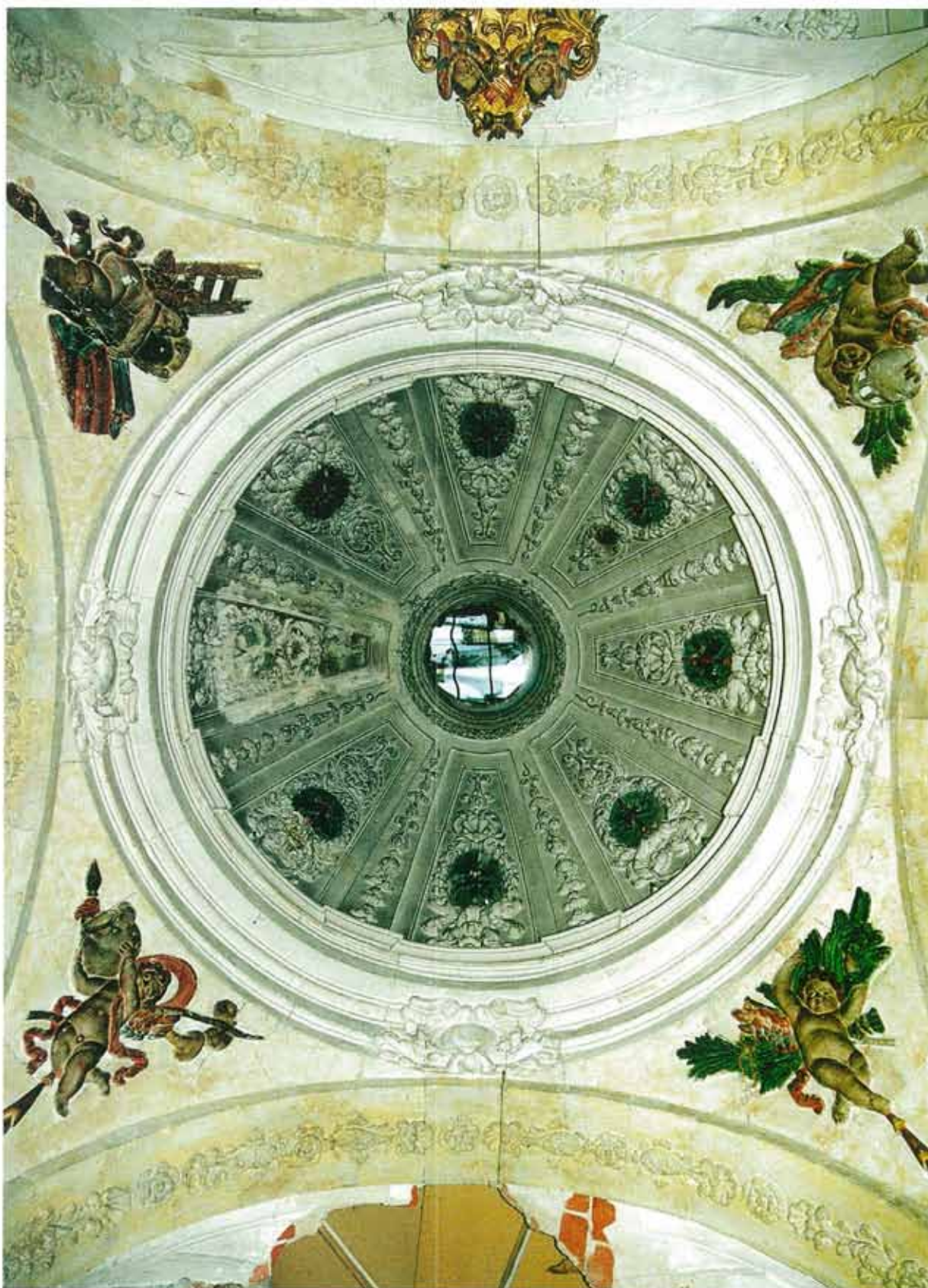
Estado previo del interior de la capilla
