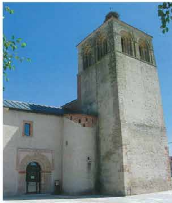
Iglesia de San Juan de Aguilafuente (Segovia). Restaurada y acondicionada en su interior como Aula Arqueológica de la villa romana de Santa Lucía
