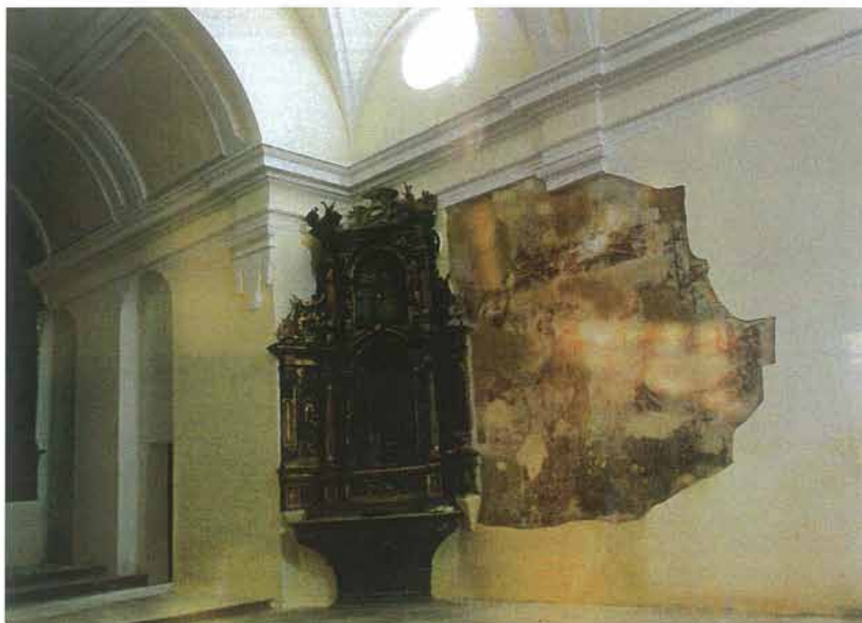
Pinturas murales. Nave central
