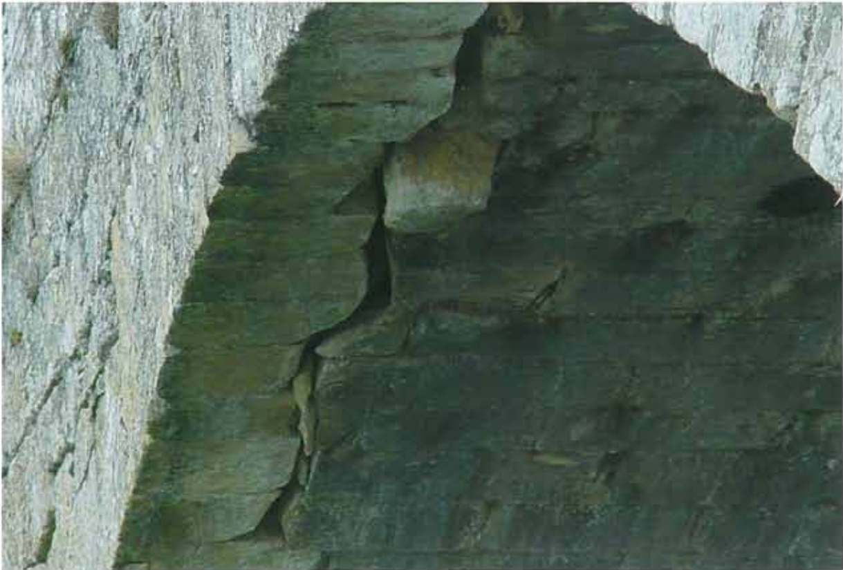
Detalle del intradós de la bóveda
