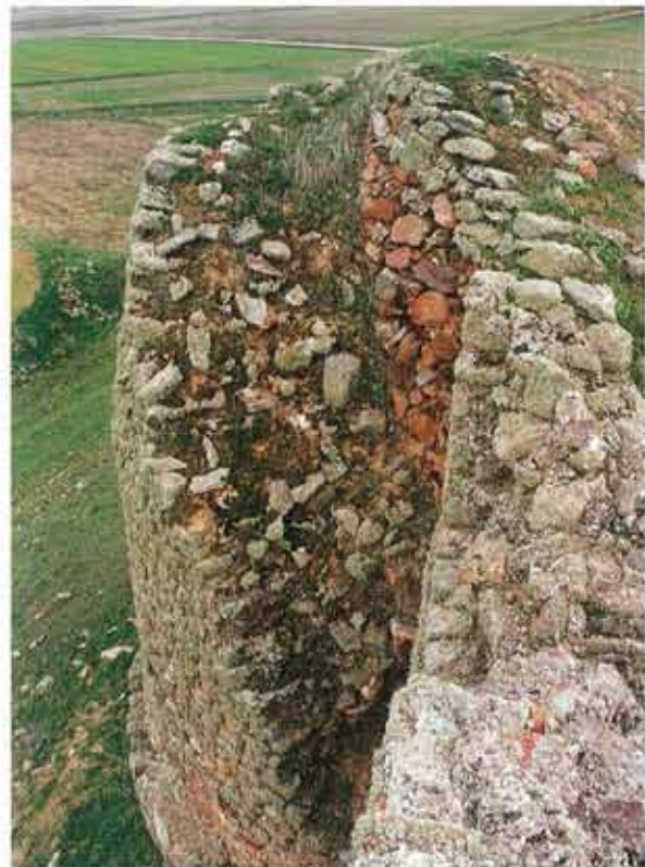
Recorrido exterior. Crestones de Muralla frente Este
