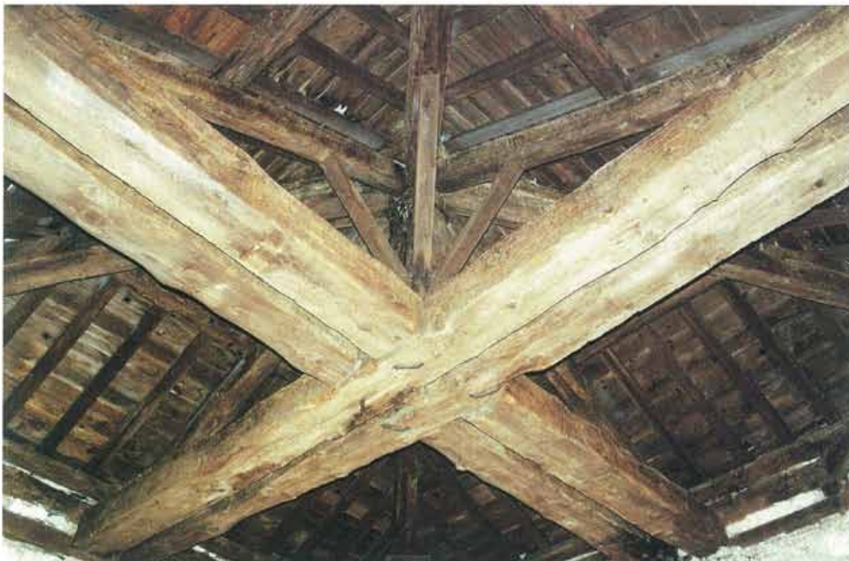
Estructura interior del chapitel de la torre
