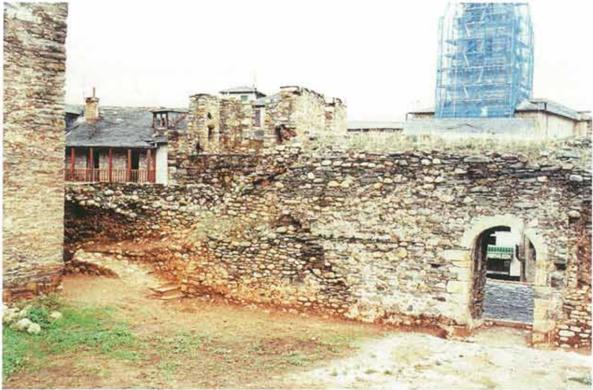
Estado inicial. Vista interior
