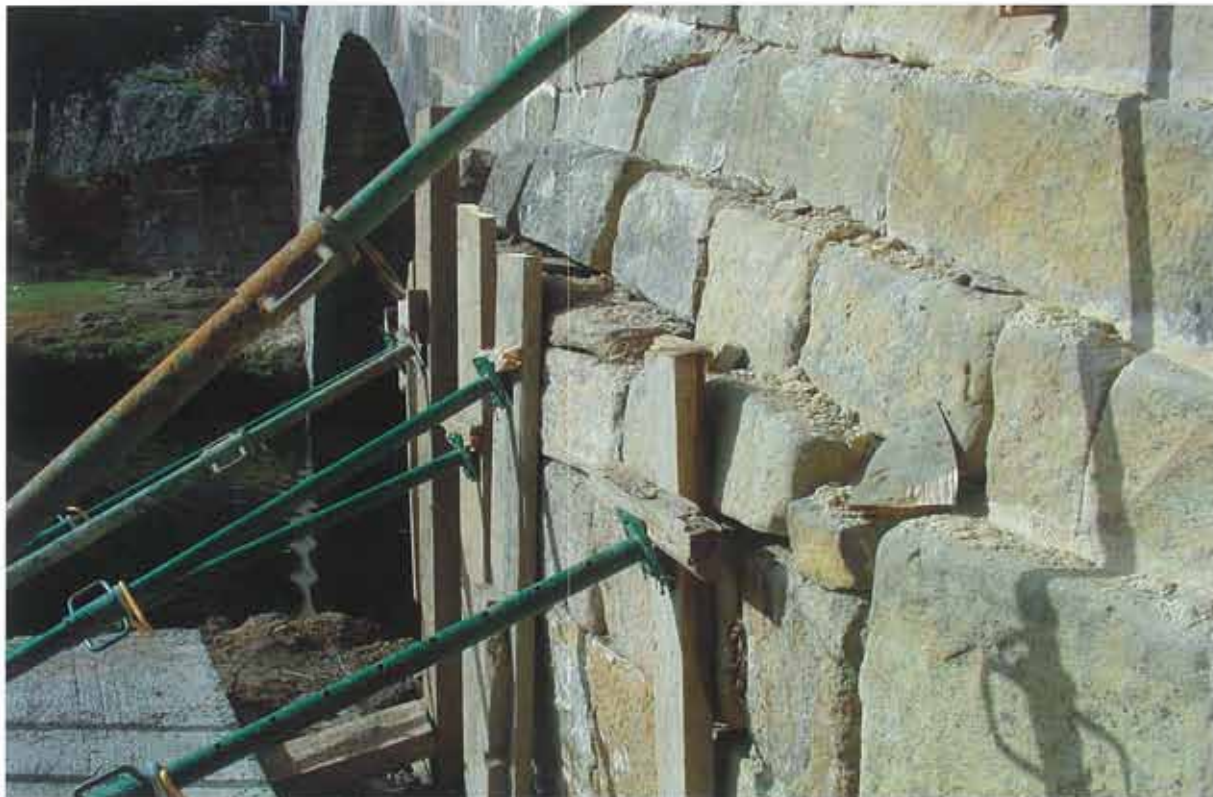
Estado previo a la restauración
