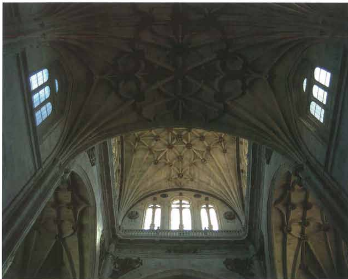
Interior de la Iglesia. Bóvedas del presbiterio y cimborrio
