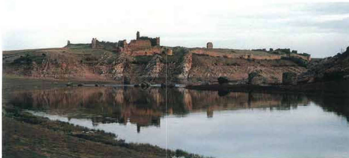
Recorrido exterior. Frente Oeste del Castillo y la Muralla desde el Río
