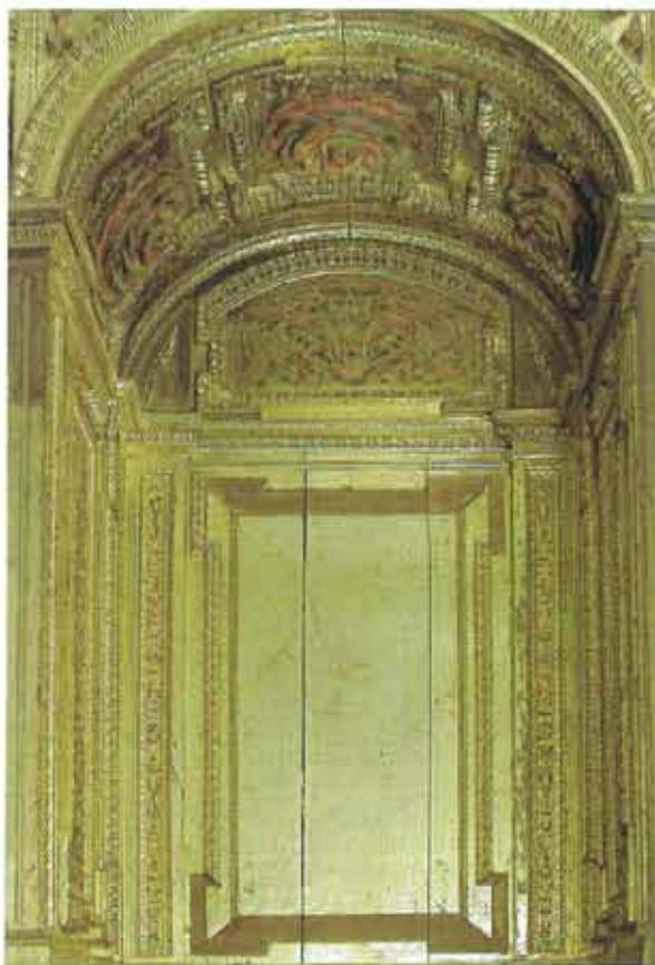
Hornacina central. Limpieza y colocación de piezas
