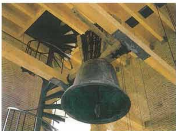
Estado reformado. Estructura de campanas
