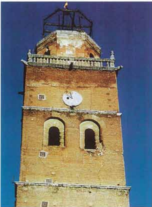
Torre. Vista sur. Estado inicial
