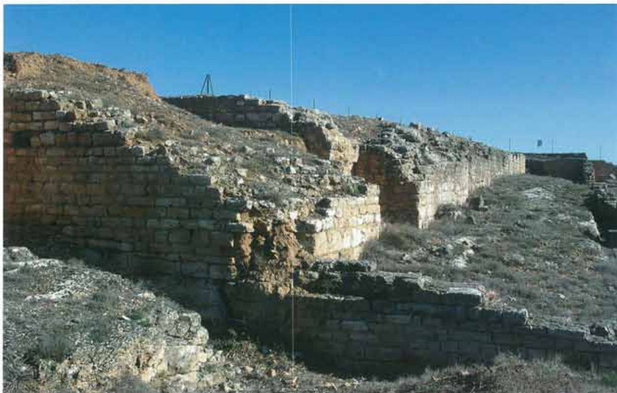
Ciudad celtibero-romana de Uxama Argaela. Basamento de la terraza del foro con restos de escaleras de acceso
