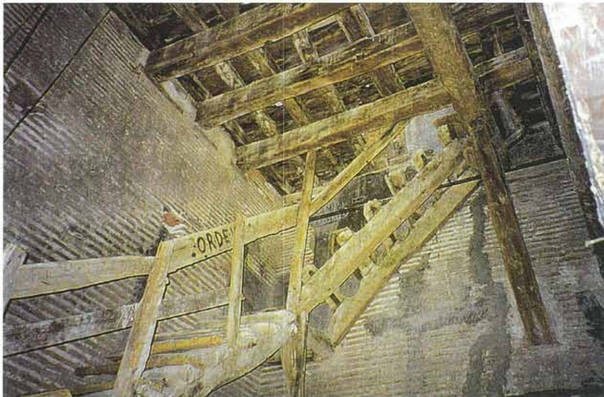
Estado inicial. Escalera de la torre
