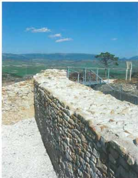
Fortaleza de Tedeja. Muralla. Pasarelas y paneles informativos
