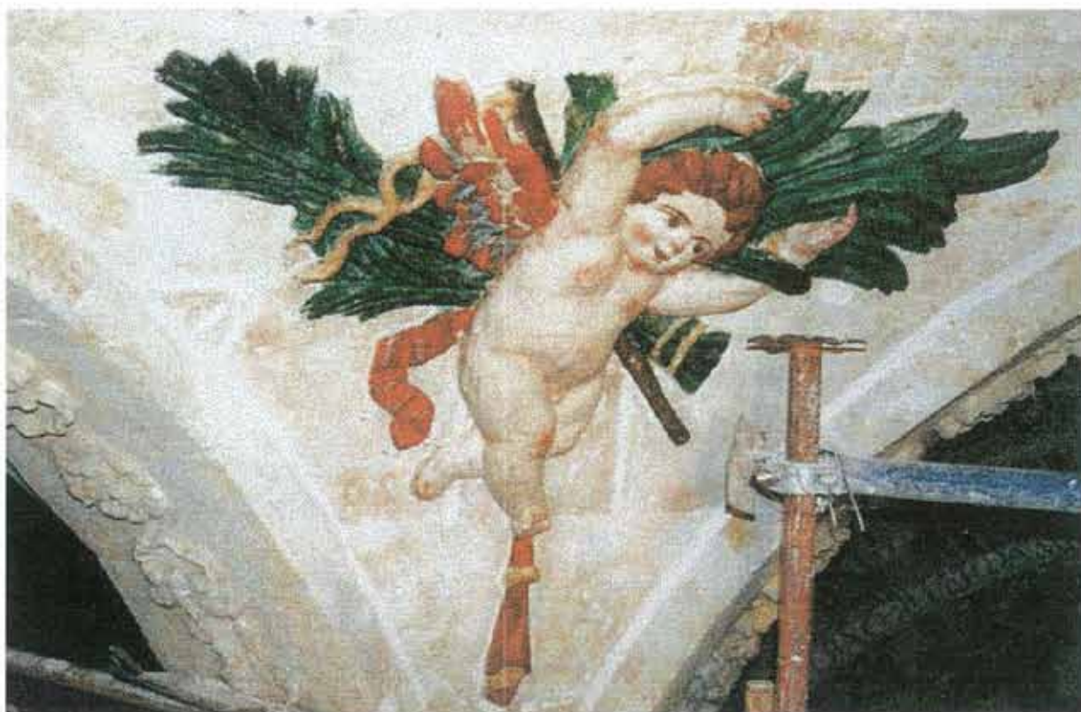
Estado tras la restauración
