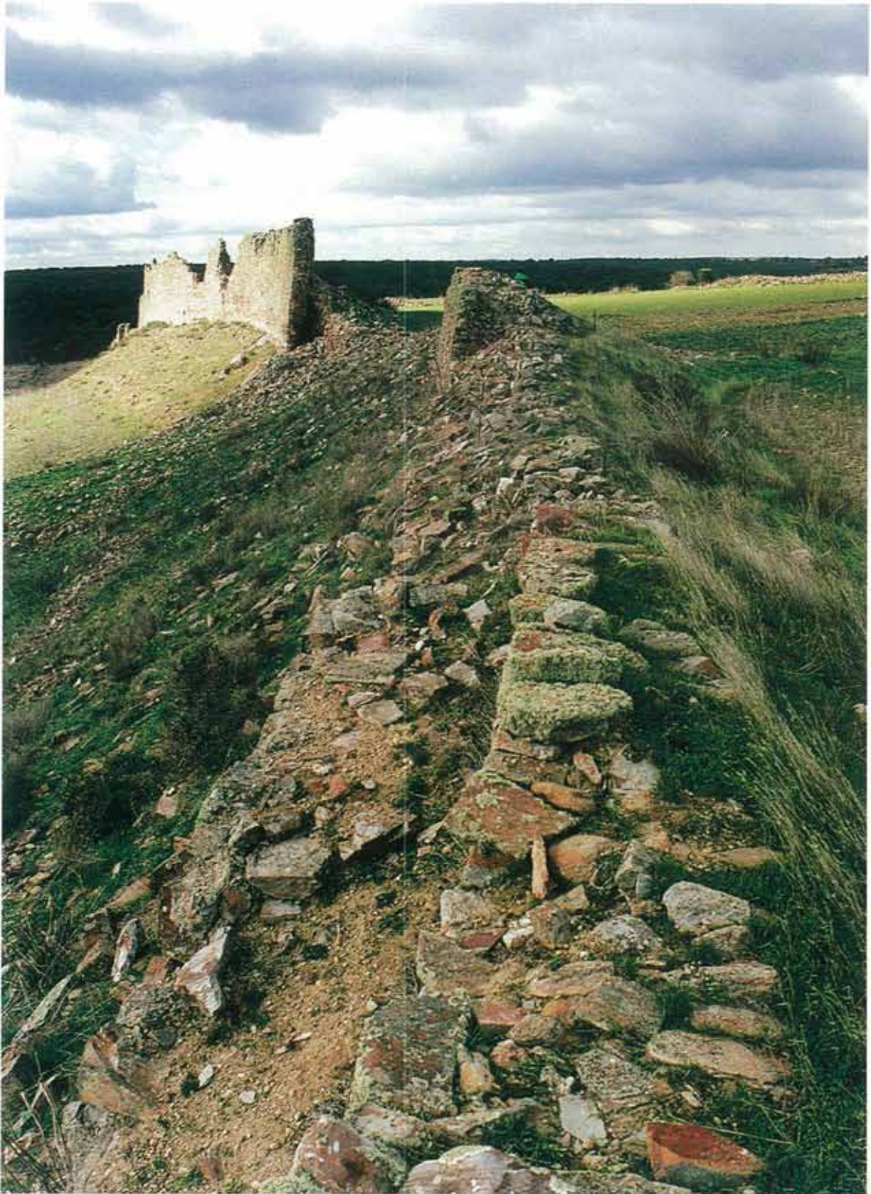
Recorrido interior del recinto. Frente Sur en dirección al Oeste
