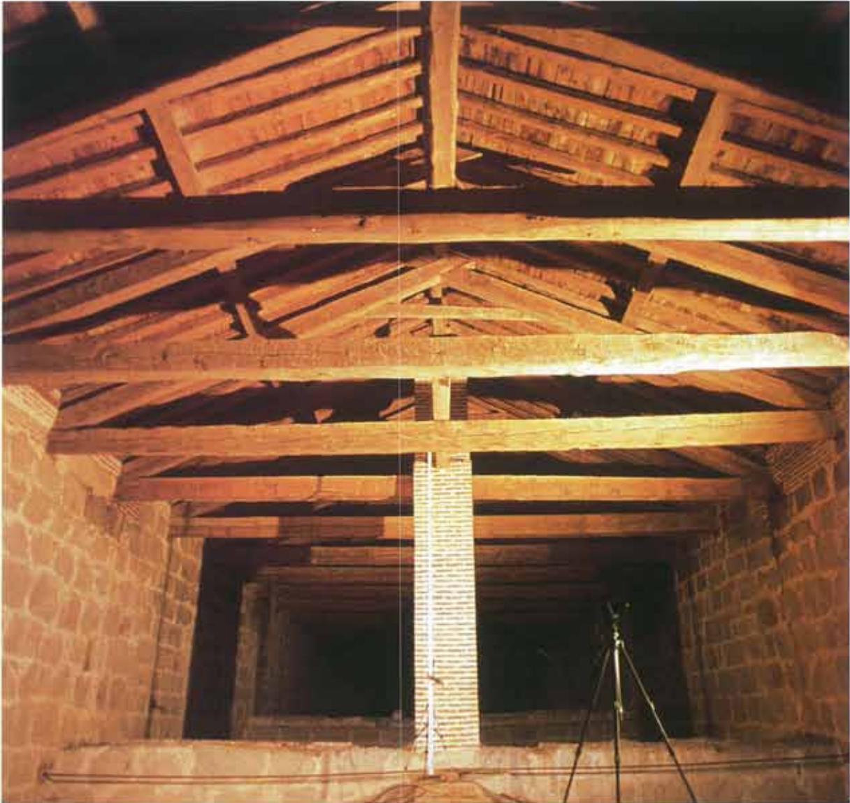
Apeo mediante pilares de ladrillo
