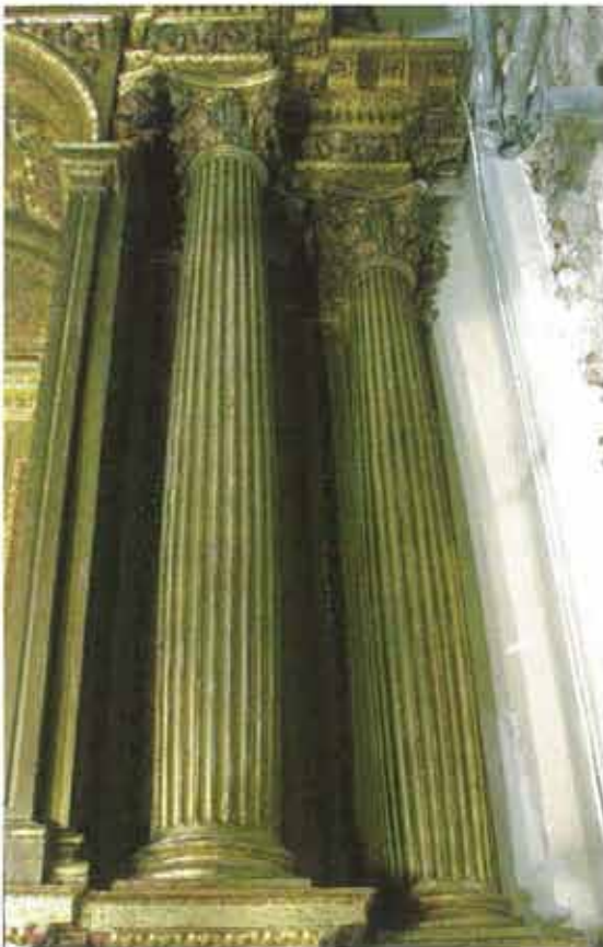
Detalle de limpieza de oro de las columnas.
