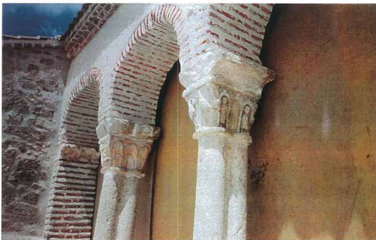
Detalle de la arcada del atrio
