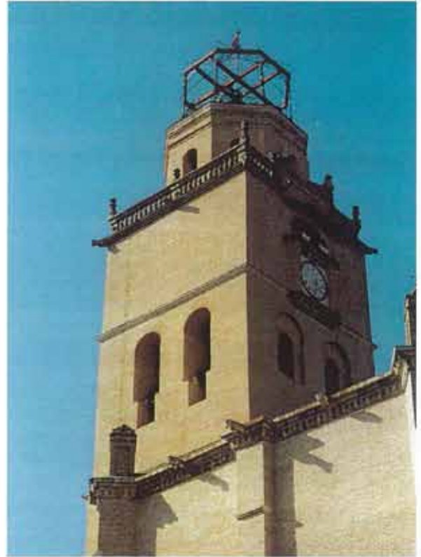
Torre. Vista noroeste. Estado final
