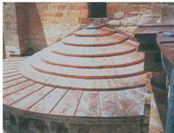
Colocación del tablero de contrachapado fenólico en remate de ábsides
