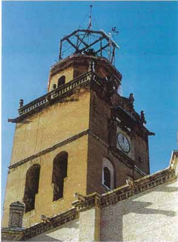
Torre. Vista noroeste. Estado inicial
