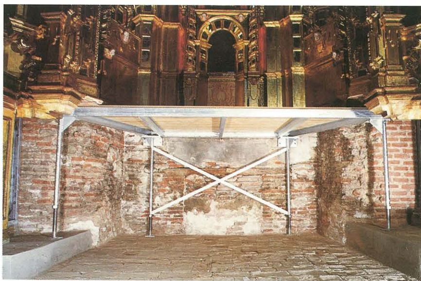
Estructura preparada para dar soporte a la hornacina superior y estructura cámara inferior.
