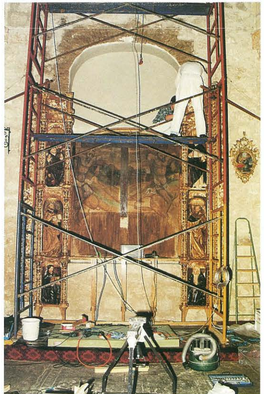
Proceso de montaje.
