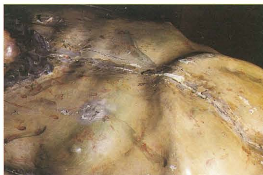
Detalle de la grieta.
