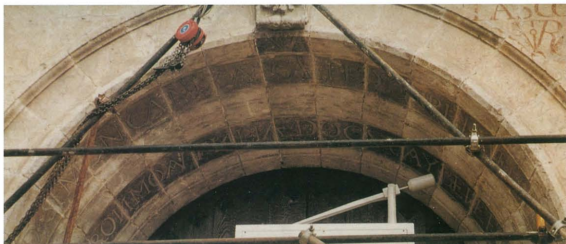
Antes de la intervención.
