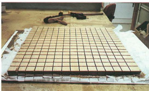
Eliminación primer soporte de traslado.
