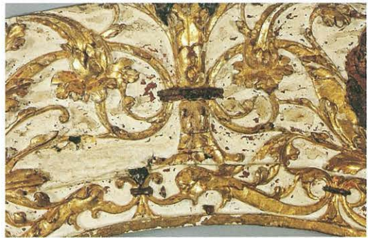
La misma pieza de la arquitectura tras la restauración.
