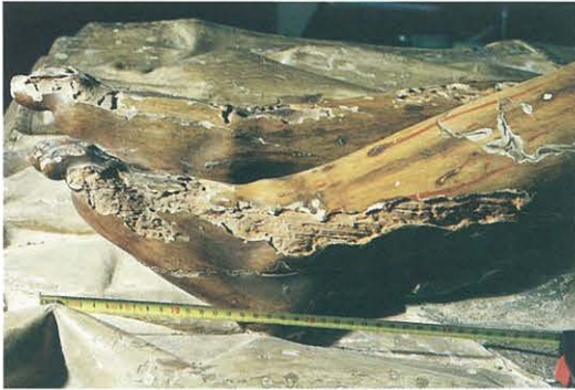
Detalle antes de la intervención.
