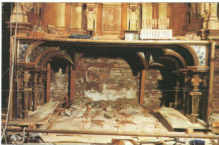
La cámara antes de la restauración.
