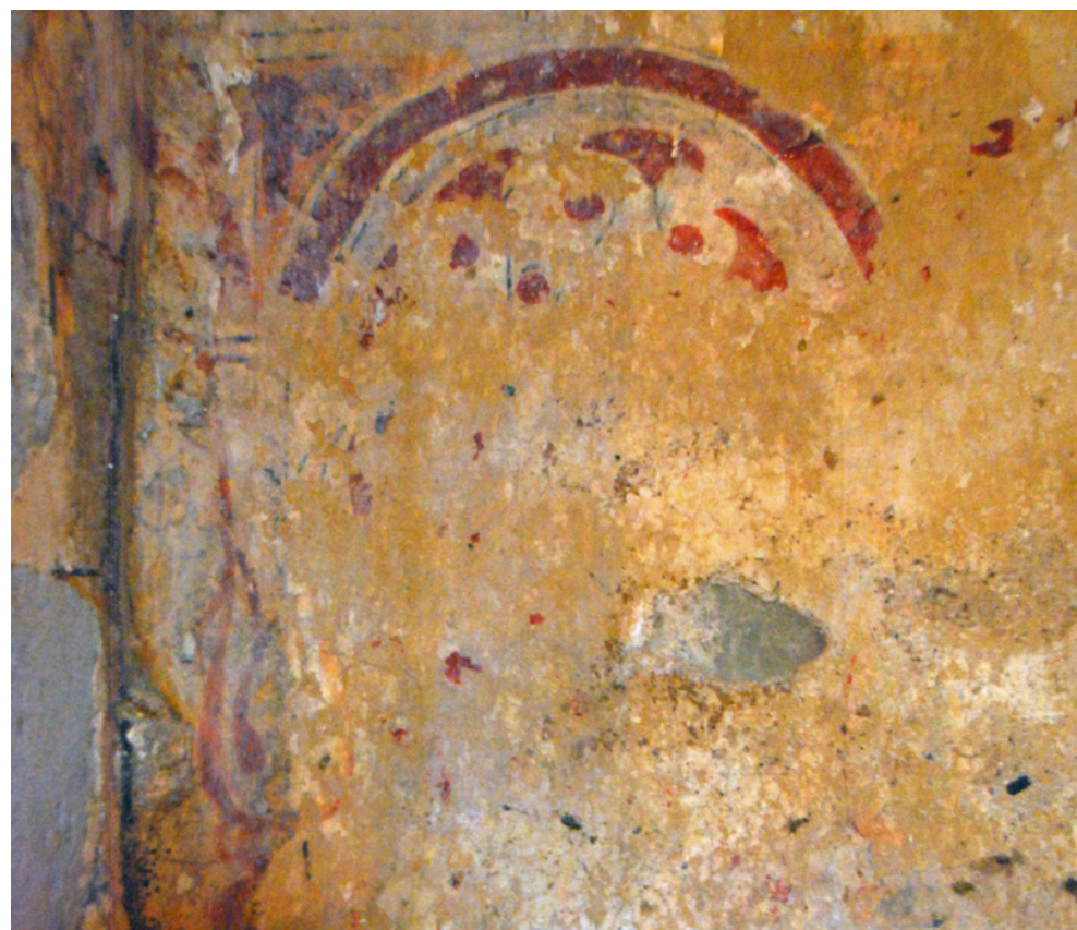
Basamento del muro izquierdo de la capilla mayor
