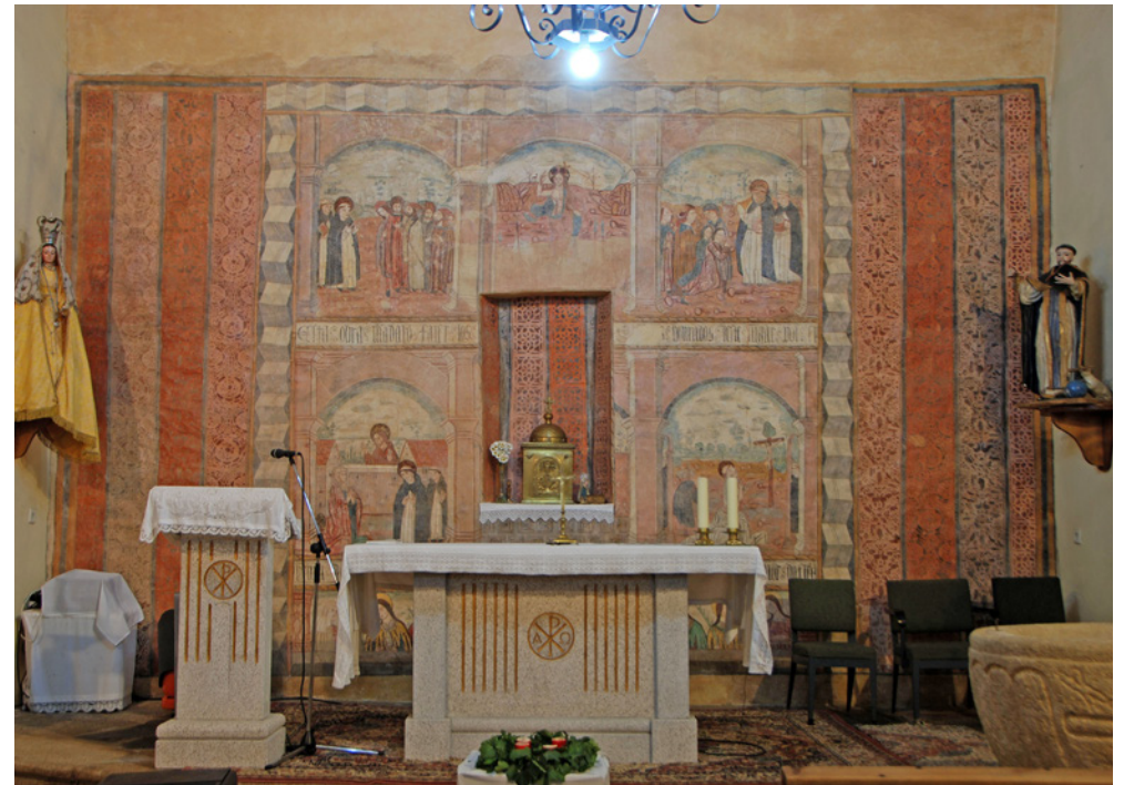
Vista general de las pinturas del testero de Vivinera
