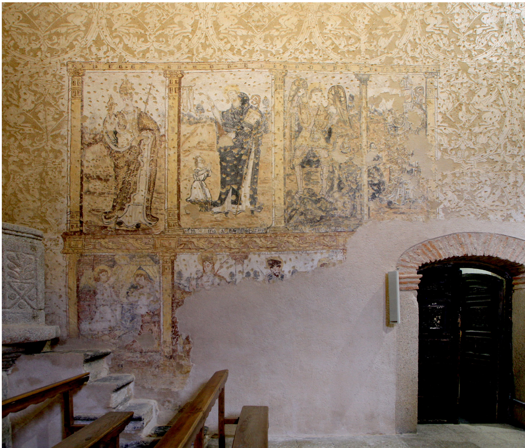
Vista general del muro del Evangelio, con acceso a la sacristía
