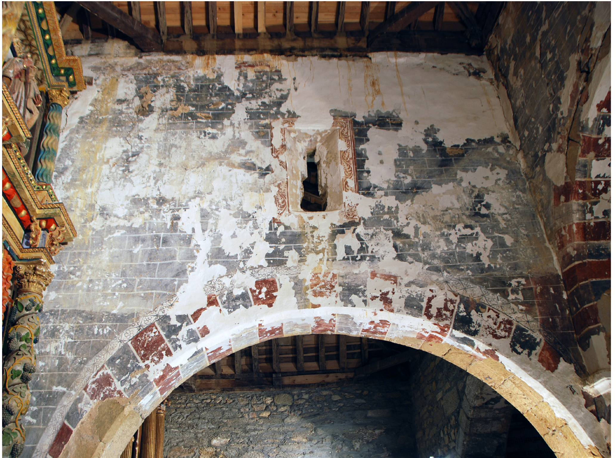
Vista general del muro derecho de la capilla mayor
