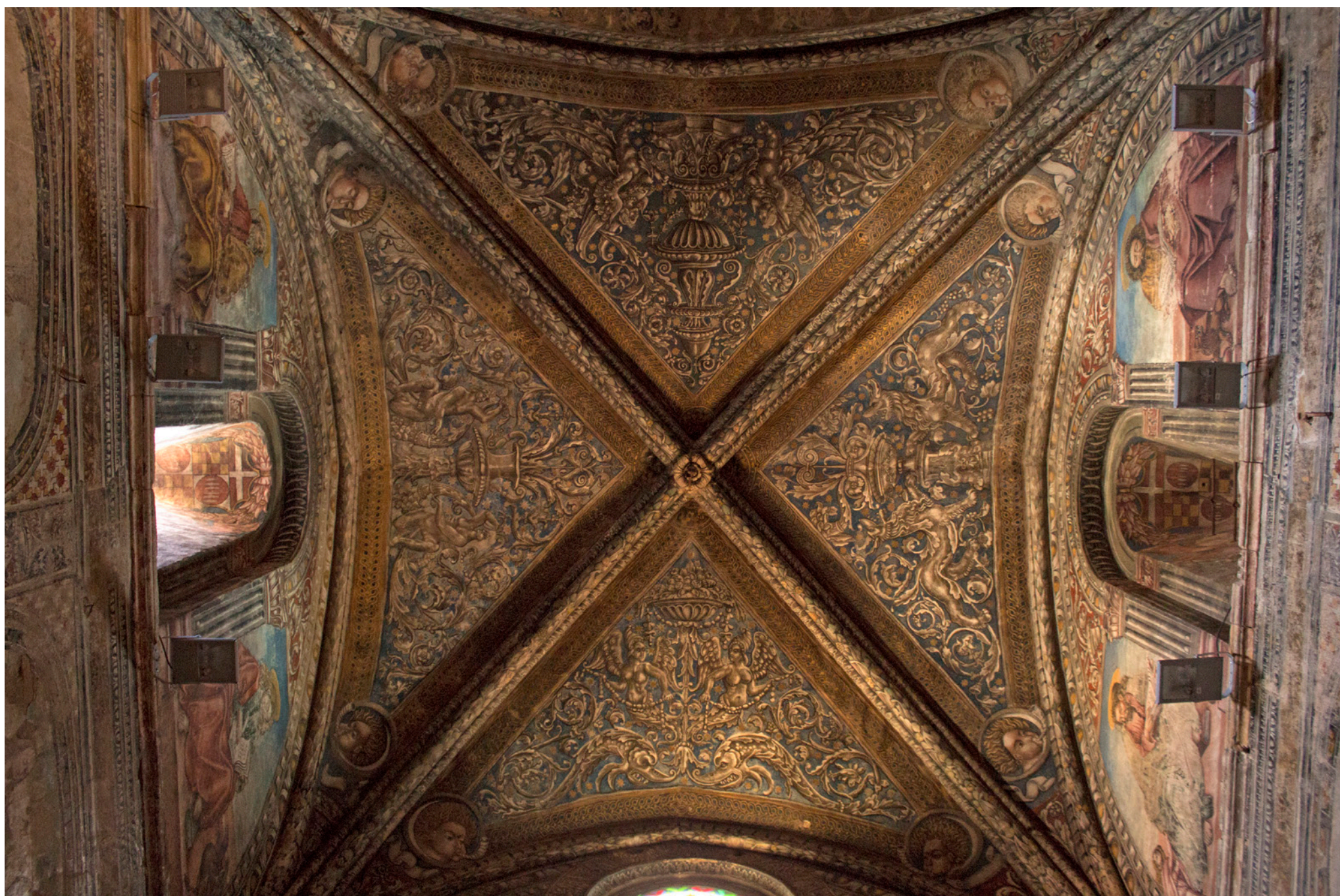
Bóveda y lunetos de la capilla mayor de la iglesia de San Juan del Mercado (Benavente) Foto: Horacio Navas Juan
