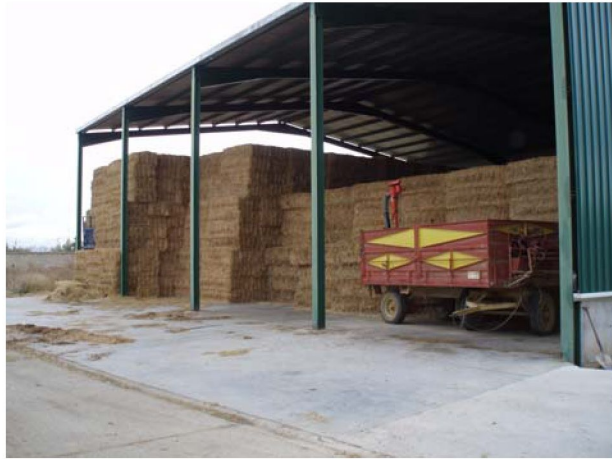
Figura 13. Henil para almacenamiento de paja y heno de la explotación
