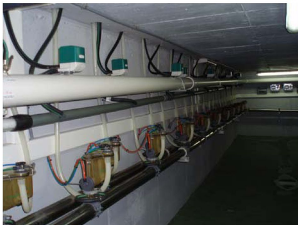
Figura 5. Piso inferior de la sala representada en figura 3. Aquí se observa la disposición del resto de accesorios necesarios en la sala de ordeño
