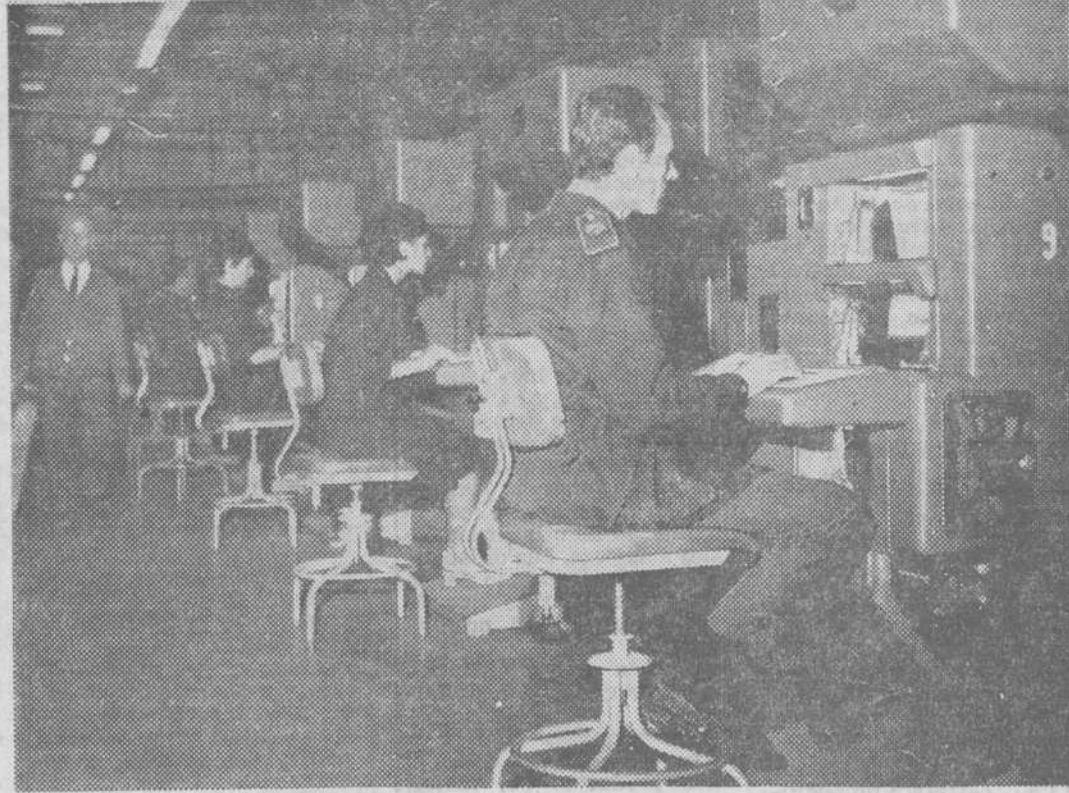
Mediante estas máquinas electrónicas, que registran el sello por medio de célula foto-eléctrica, los empleados de Correos de la Central de Madrid, llevan el control de los millones de objetos postales que pasan por sus manos. — (Foto ELIO HISPANIA PRESS)
