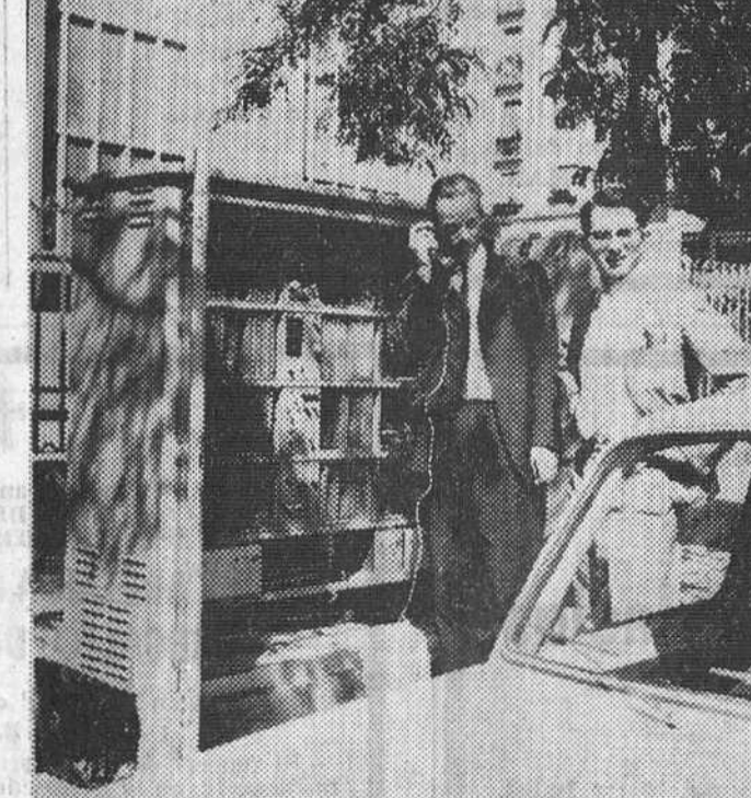
Madrid. — El Ayuntamiento de Madrid toma las medidas oportunas para aliviar la situación caótica del tráfico rodado. Para ello están instalando modernísimos aparatos Digiflex (ya hay uno en Conde Peñalver esquina a Diego de León que controla seis cruces: Francisco Silveira desde General Oraa a Lista). Estos aparatos darán órdenes a las cajas de mando situadas en cada cruce, regulando así el tráfico de una forma más dinámica y conveniente en cada momento. Todo ello enlazado desde la sala calculadora instalada en el Ayuntamiento. En la fotografía, el modernísimo Digiflex instalado en Conde de Peñalver. — (Foto CIFRA)
