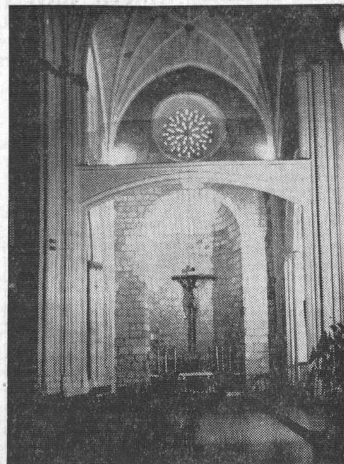
DESPUES DE LA RESTAURACION
