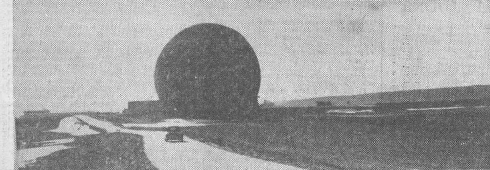
Al fondo, la gran esfera de plástico que aloja una emisora de radio del servicio alemán de Telecomunicaciones y la antena parabólica de 290 toneladas de peso que, por primera vez, recoge en Alemania señales televisadas a través de los satélites o transmite de una sola vez mil conferencias telefónicas. La esfera mide sesenta metros de diámetro, tiene dos milímetros de espesor, se mantiene hinchada por presión y se levanta en las cañanías del lago Ammer (Baviera). (Foto Fiel)
