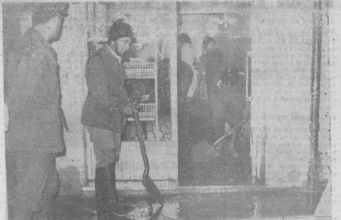
Vista de uno de los establecimientos afectados por la imprevista inundación, provocada por una excavadora al trabajar sin protección alguna, sobre la conducción general de la ciudad de agua a la ciudad, en la calle de San Francisco.
