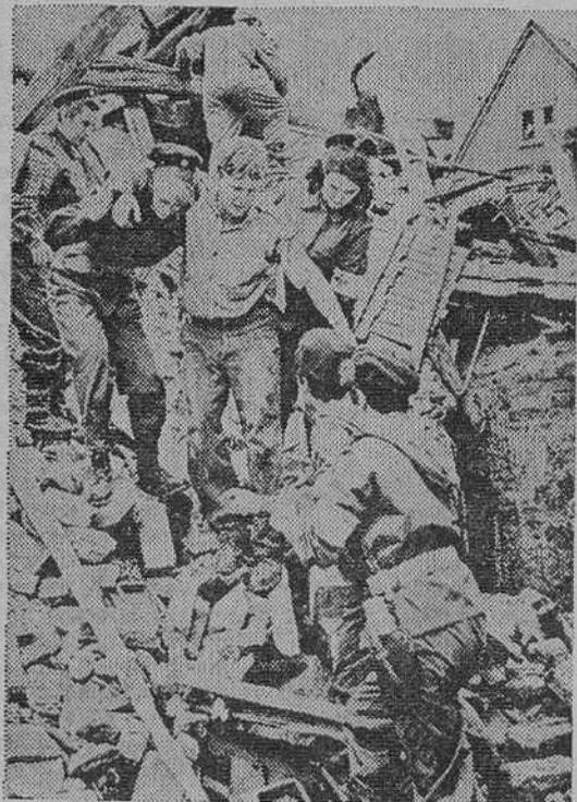
ENTRE LOS ESCOMBROS
