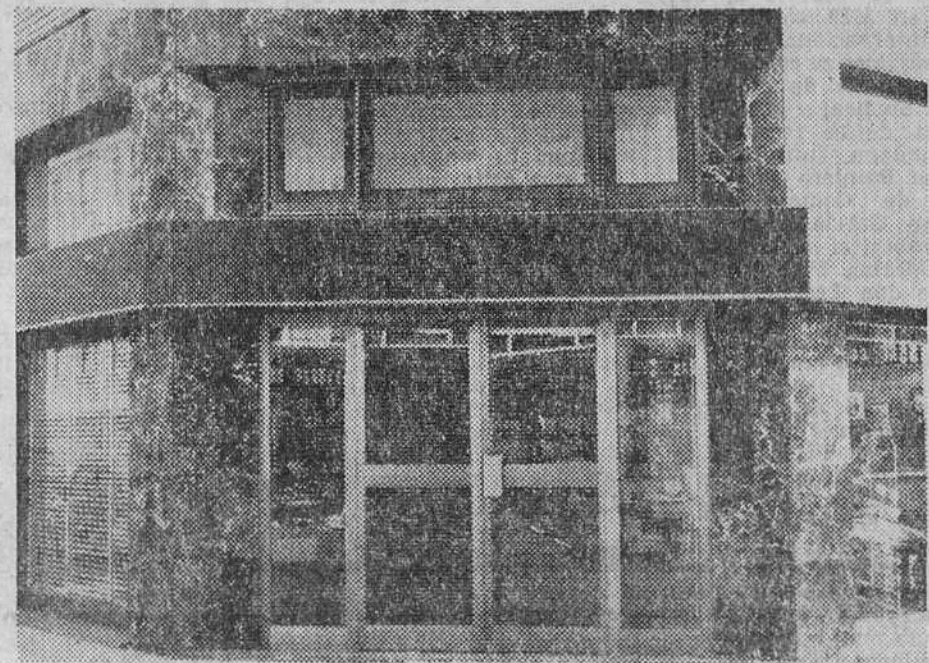
FACHADA DE CHARCUTERIA MANTEQUERIA CAHES
