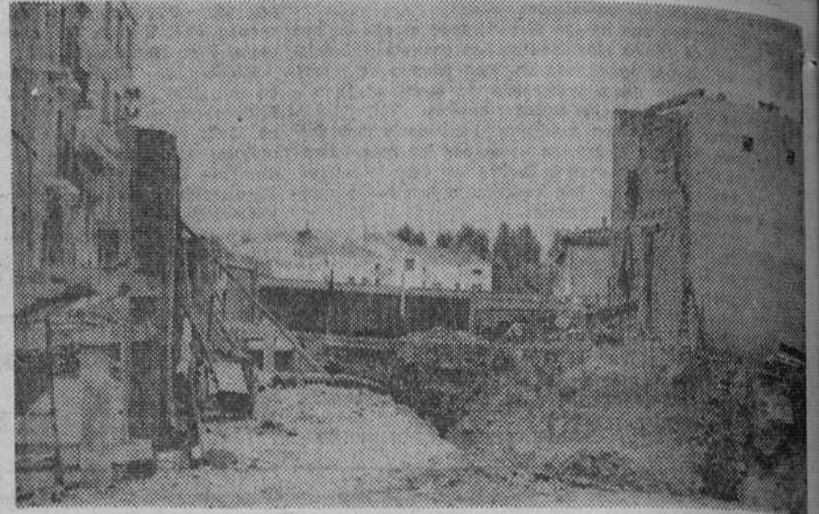
Aspecto que ofrecían las obras de la calle de Santo Cristo, de Aranda de Duero, de que damos cuenta en esta sección.
