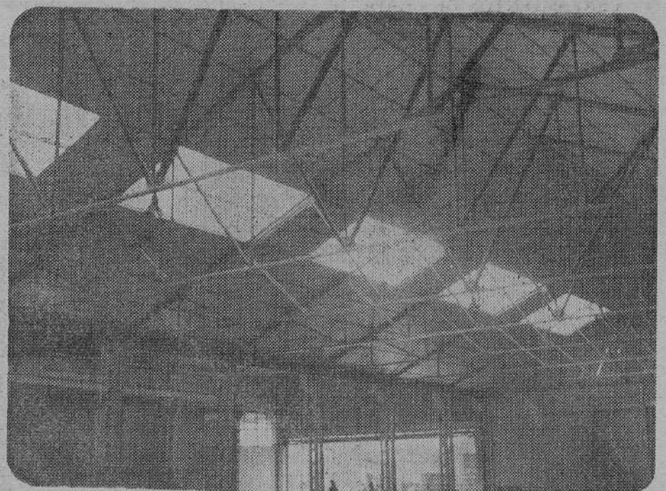
ESTACION TERMINAL DE TRANSPORTES OCHOA. CUBIERTA URALITA Y TECHO ALUMISOL DE FIBRAS MINERALES.
