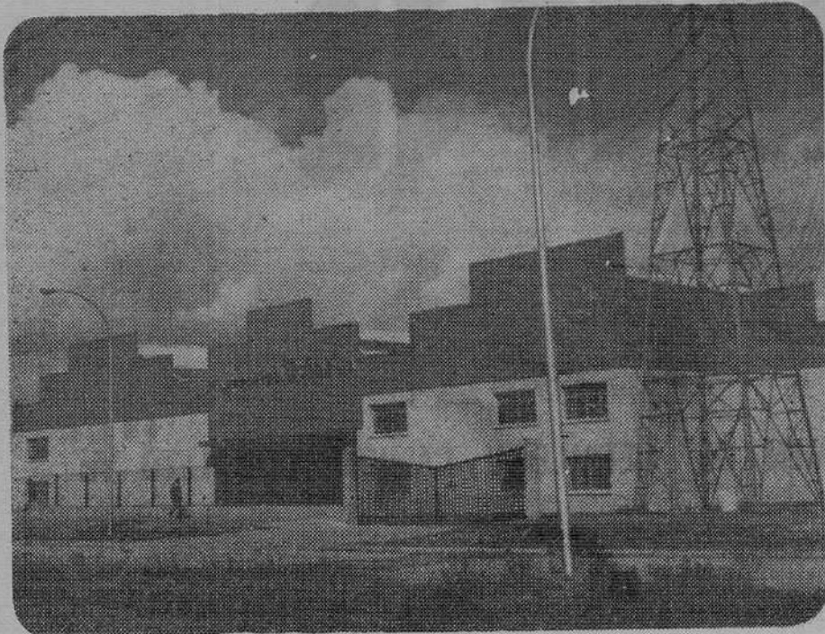
CERRAMIENTOS DE CHAPA DE LA FACHADAS DE TRANSPORTES OCHOA, REALIZADOS POR TECZONE.
