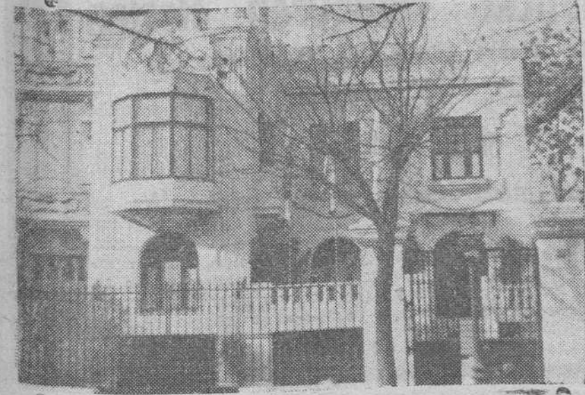
Fachada del nuevo local de la Escuela de Periodismo, inaugurada recientemente en Madrid en la calle de Zurbarán.—(Foto S. O. F.)
