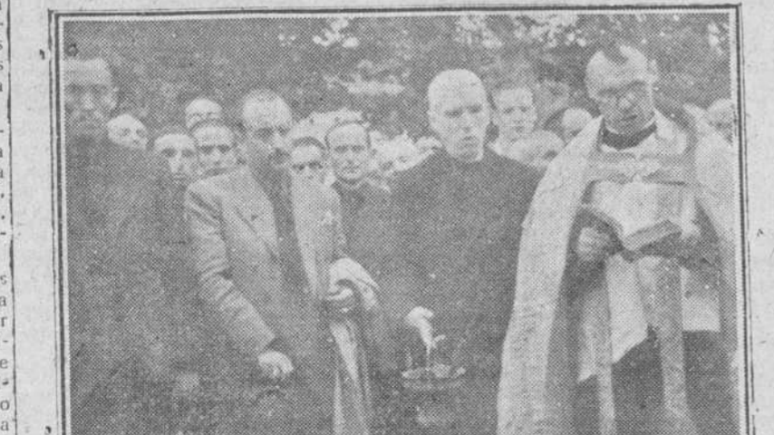
Bajo la presidencia del gobernador civil y jefe provincial del Movimiento, se efectuó ayer la inauguración del servicio de suministro de energía eléctrica de Tosantos, instalado por la entidad "Nueva Electrica de Villasar".
