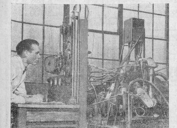
Pruebas efectuadas sobre un motor de un cilindro para observar el funcionamiento de sus partes. Los instrumentos de control en el papel, indican la velocidad, consumo de gasolina y la temperatura concentrada en varias partes del motor. (Foto Calpe).
