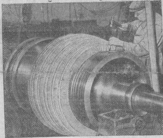
Un obrero mecánico monta una turbina de baja presión en los talleres de la Vickers-Armstrong, en Barrow-in-Furness (Inglaterra).
