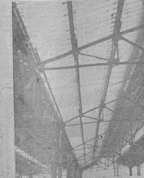
La luz penetra en el interior de la nave a través de las placas de "VERONDULIT" colocadas en la cubierta.
