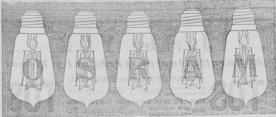
La lámpara OSRAM es la primera que fabricó e introdujo en el mercado lámparas de filamento de hilo estirado, que la hace insensible a toda clase de golpes y vibraciones.
