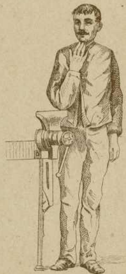
Manera de tomar la altura del torno
