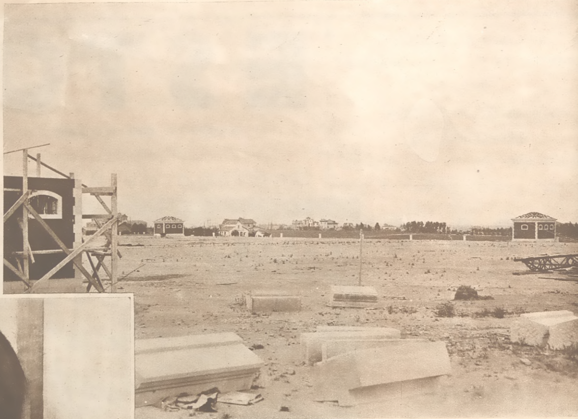
La planicie del cuarto depósito, ya cubierto. Sus límites están marcados por las torretas que se ven en la fotografía
