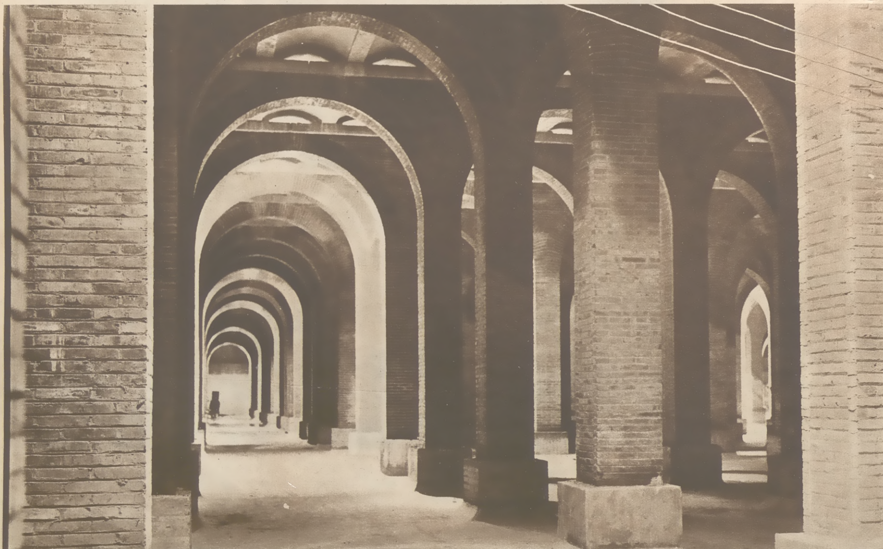
Un aspecto del interior del cuarto depósito del Canal del Lozoya. Está emplazado en las inmediaciones del Hotel del Negro, con arreglo a los más modernos adelantos de la ingeniería hidráulica
