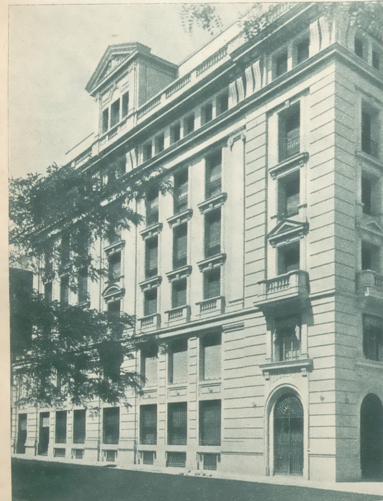
«El Debate», después de sucesivas y rápidas ampliaciones de local y maquinaria, se ha instalado en lo más céntrico de Madrid, en este suntuoso edificio, en cuyos sótanos funciona una de las dos mejores máquinas del mundo
