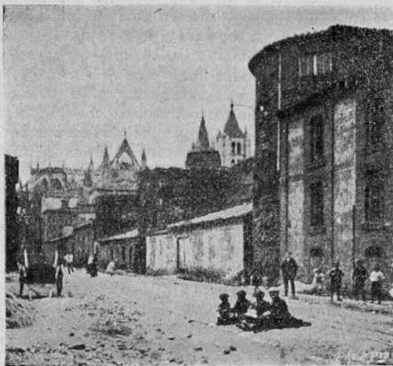
PASEO «DETRÁS DE LOS CUBOS»
