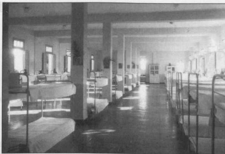
Instalaciones del Lazareto de Tisconia, La Habana (ANC).
