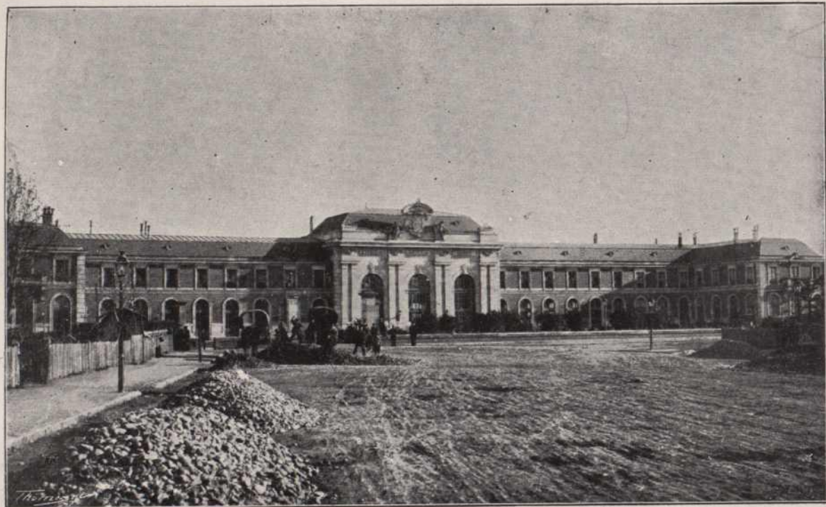
Estación del Ferrocarril del Norte
