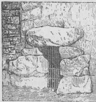
Muros ciclópeos en Tarragona.
