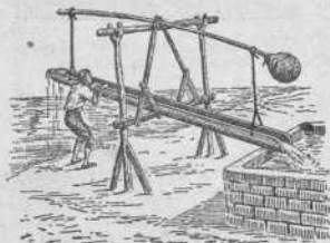
Canalón con contrapeso,
