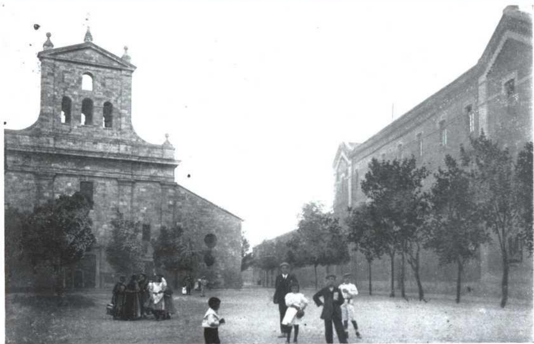
A su izquierda la iglesia con sus tres puertas abiertas entre pilastres y cornisamento de orden dórico, rematada por una espadaña con frontón triangular.
