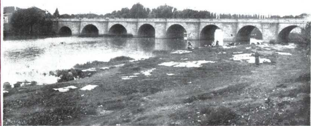
Es el más importante de los tres que cruzan el Carrión, constando de once arcos de sillaría y comunica la ciudad con el barrio de Allende el Río.
