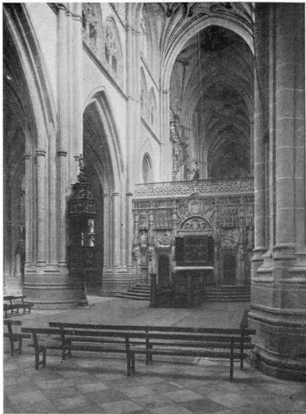
CATEDRAL. NAVE PRINCIPAL.
