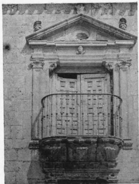
Balcon de la fachada pral.
