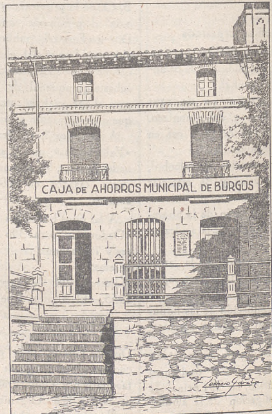
Oficina donde está instalada la Caja de Ahorros Municipal, en Lerma
