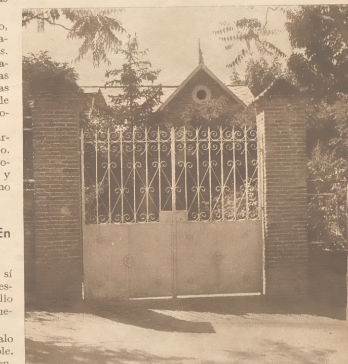
Entrada del hotel «Floresta», del ex diputado socialista don Gabriel Morón, en la Ciudad Lineal, donde fué descubierto un laboratorio para la fabricación de bombas
