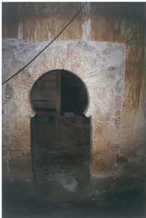
Los paramentos de mampostería se han cosido mediante grapas en las grietas, y está previsto la ejecución de un nuevo arco de triunfo entre el ábside y la nave, para el que se ha tomado como modelo el de San Baudelio, ya que la proporción entre los ábsides y la zona con pinturas de San Miguel y la de San Baudelio es semejante.
