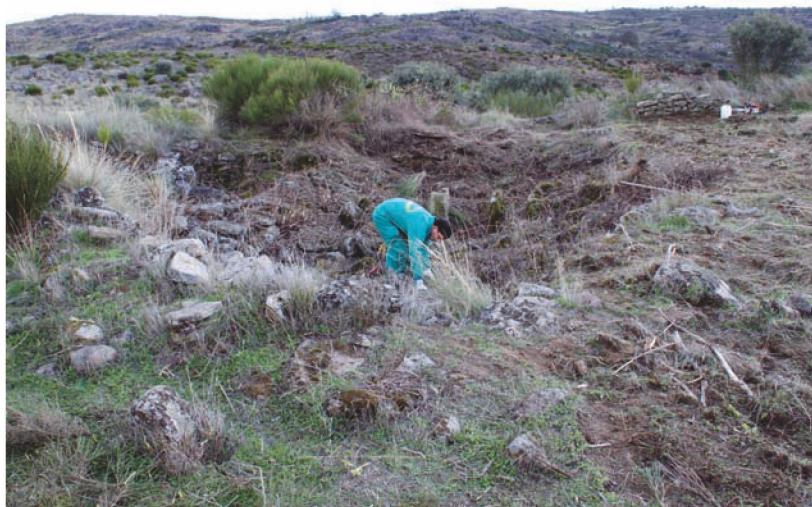
El Fuerte Nuevo en el inicio de los trabajos de desescombro
