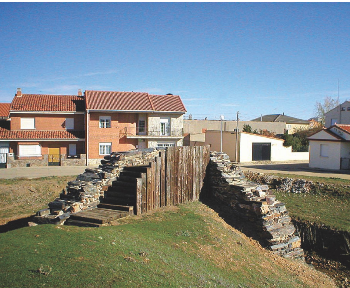
Consolidación y acceso al baluarte de Santa Engracia
