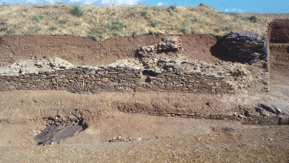
Detalle del baluarte de San Amaro. Obsérvese la “costilla” y el pozo abierto en el foso
