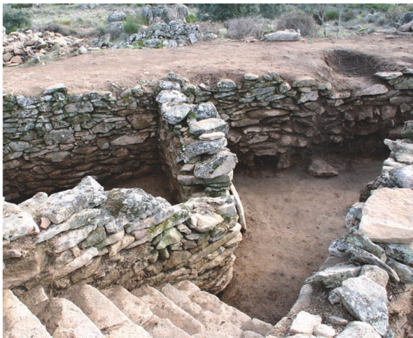
Detalles constructivos del interior del fuerte antes de su consolidación
