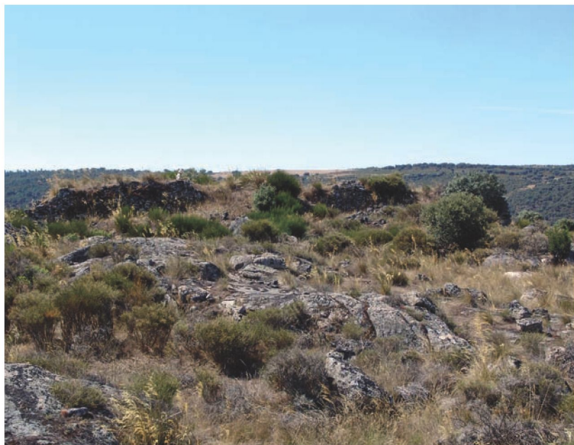
El Fuerte Nuevo: estado previo a los trabajos de 2009-2010
