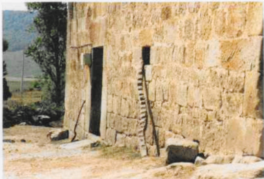
Fig. 174. Escalerilla de acceso al gallinero. Cilleruelo de Bezana
