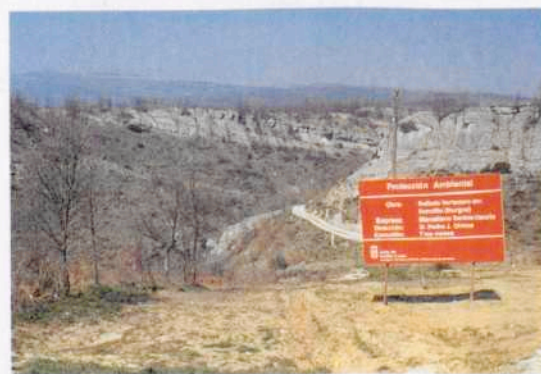
Fig. 175. Escombrera sellada. Soncillo
