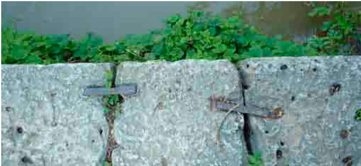
DETALLE DE UNIÓN ENTRE SILLARES MEDIANTE GRAPAS DE ACERO.
