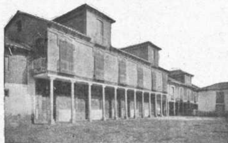
Fachada del edificio en donde están instaladas las fábricas
