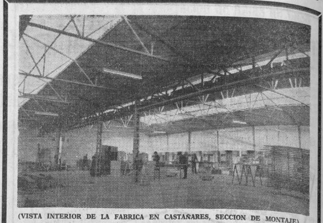
(VISTA INTERIOR DE LA FABRICA EN CASTANARES, SECCION DE MONTAJE)
