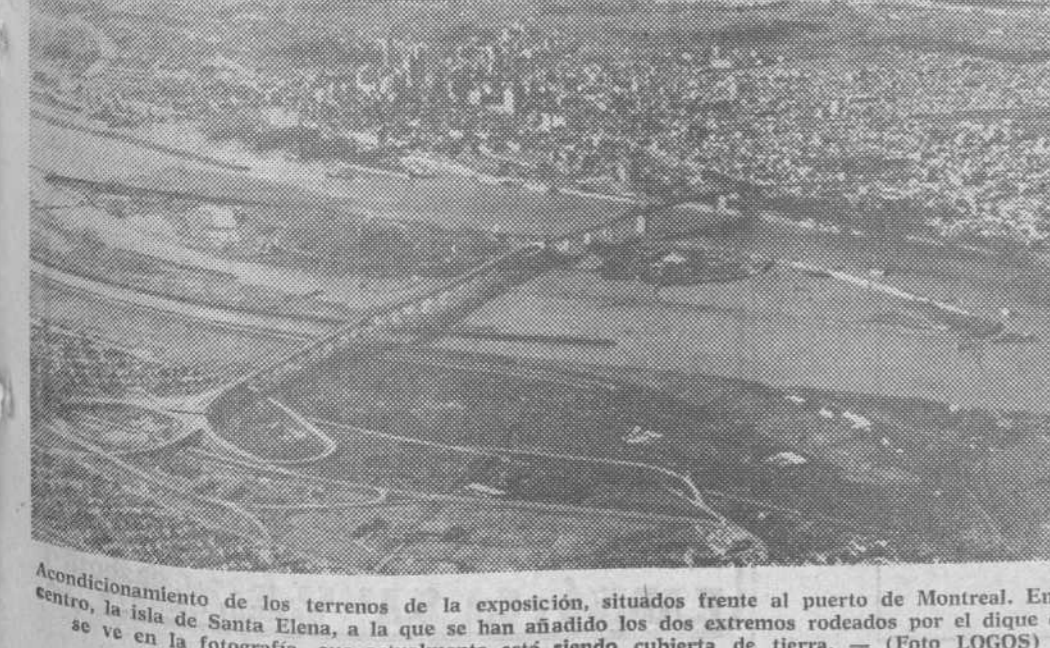
Acondicionamiento de los terrenos de la exposición, situados frente al puerto de Montreal. En el centro, la isla de Santa Elena, a la que se han añadido los dos extremos rodeados por el dique que se ve en la fotografía, que actualmente está siendo cubierta de tierra. — (Foto LOGOS)
