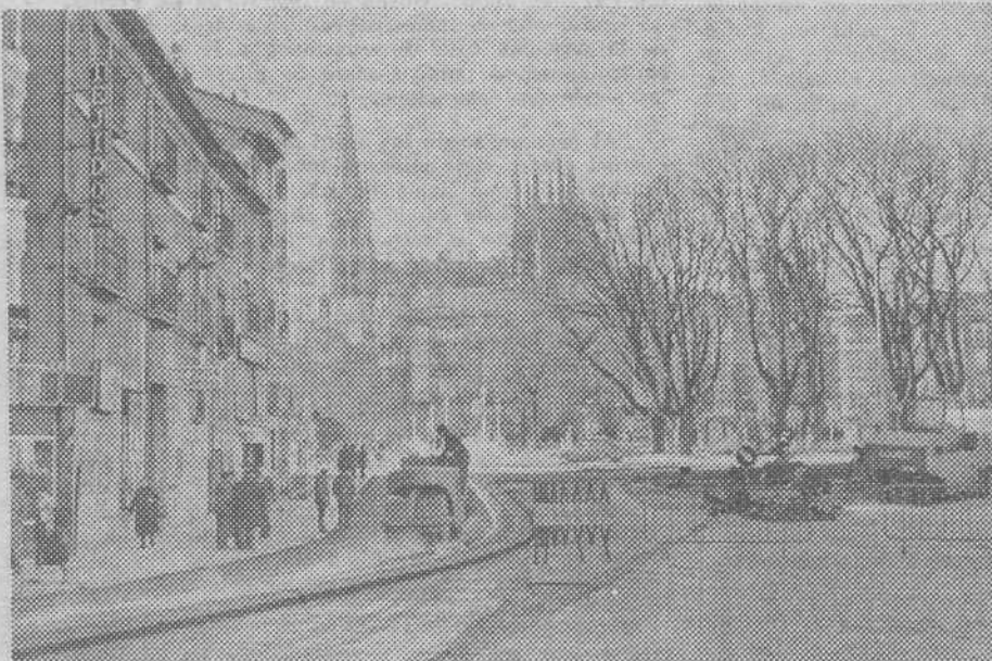
He aquí un aspecto general de los trabajos de repavimentación del firme de la plaza de Vega, uno de los puntos neurálgicos de la travesía de la carretera nacional Madrid-Irún y cuyo lastimoso estado ha movido a la Jefatura provincial de Carreteras a cooperar en el arreglo de la maltratada calzada. — (Foto FEDE)
