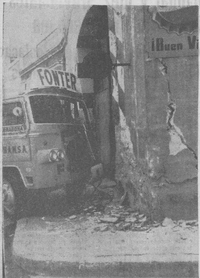
Al fallarle los frenos a un camión a su paso por la calle General Mola de Tarragona, chocó violentamente contra la fachada de un taller mecánico, sufriendo notables daños, y quedando la fachada en lamentable estado. El conductor resultó ileso aunque con lesiones leves en una de sus piernas. En la foto vemos el estado en que quedó el camión. — (Foto Fiel)
