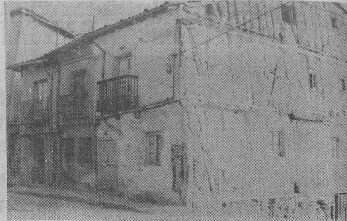
Una de las construcciones de la época medieval en cuya fachada se aprecia la construcción por medio de adobes y madera. — (Foto Reyes)
