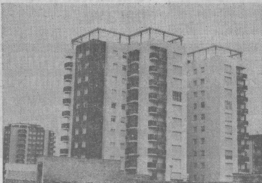
Bloques de viviendas sites en el moderno polígono residencial. — (Foto Reyes)
