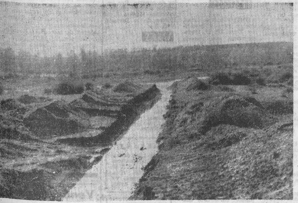
Las aguas del Pico, desviadas del polígono industrial, desembocan ahora en el río Arlanzón a la altura del cauce de Castañares. La conducción se verifica a través de la línea excavada en las primeras obras de construcción del canal que protegerá a las fábricas de aquel polígono. (Foto FEDE)
