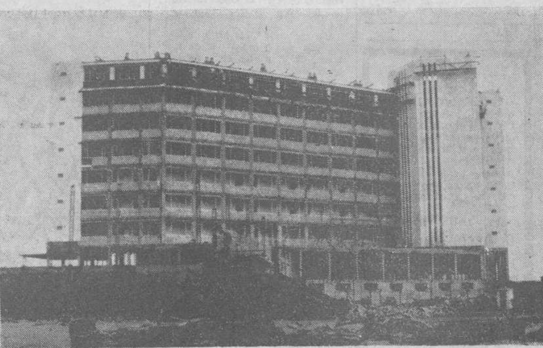
La Unión (Murcia).—En la Manga del Mar Menor, unos mil quinientos obreros trabajan con gran actividad para dejar a punto apartamentos y «bungalows» a fin de que estén terminados y puedan ser utilizados en la próxima estación estival. En la «foto», un aspecto del lugar, que cambia de día a día, en un esfuerzo por ofrecer al turista nacional y extranjero comodidades y facilidades.—(Foto Cifra)
