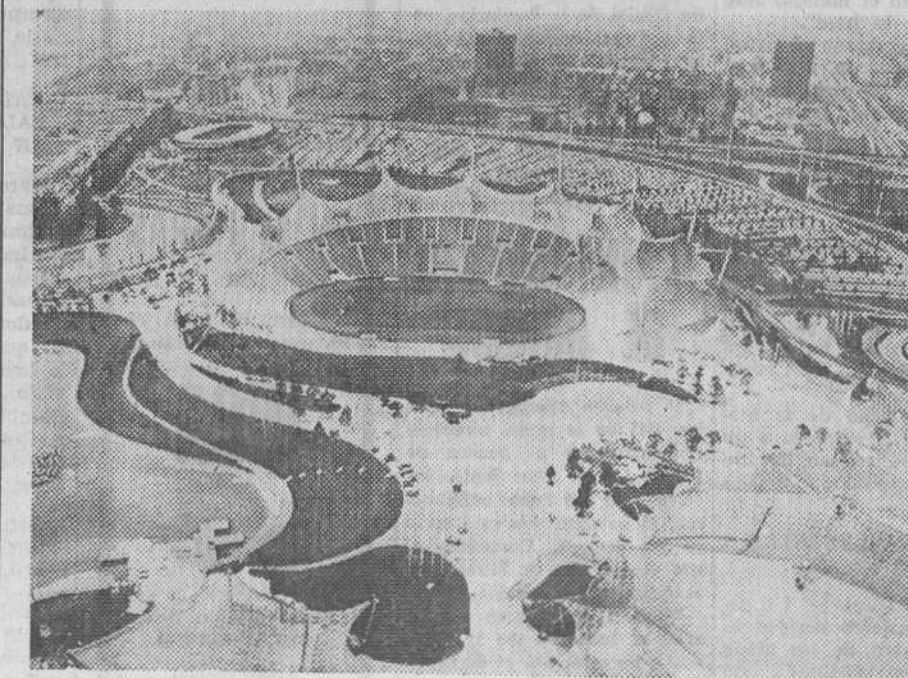
Ya están completamente terminadas las instalaciones olímpicas de Munich. La compañía constructora acaba de realizar la entrega oficial de las mismas al Comité Olímpico nacional de Alemania. He aquí una vista general de las mismas con el fabuloso Estadio Olímpico en el centro. Del 26 de Agosto al 10 de Septiembre la atención del Mundo deportivo estará centrada en este lugar. 80 países han contratado ya la transmisión en directo por la televisión de la Olimpiada. — (Foto FIEL).
