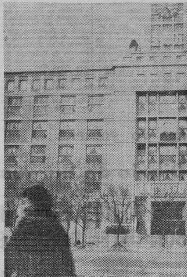
Este es el edificio de la PTT en Pekín que ha sido habilitado como centro de Prensa para la visita de Richard Nixon a la China continental. En primer plano se ve a un ciclista, su cara cubierta con una máscara a causa del frío, 15 bajo cero cuando se tomó esta foto. — (Foto Efe)
