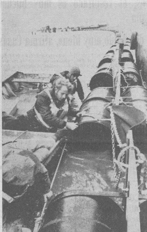
Venice (Lousiana). — Los trabajadores de la Chevron Oil montan una cadena de barriles para formar así una barrera flotante, para el control del petróleo perdido. Se está colocando una barrera de 500 pies en el Golfo de Méjico, para combatir la polución desde la ardiente plataforma de combustible. Los intentos para cortar el fuego, con explosivos se ha aplazado debido al mal tiempo. — (Telefoto UPI-CIFRA)
