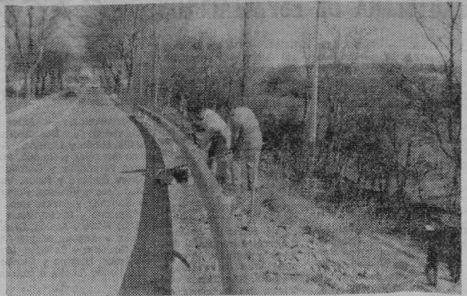
En las últimas horas se han llevado a cabo los trabajos de colocación de vallas protectoras en la carretera que va desde Burgos al Monasterio de San Pedro de Cardena. A la altura de la ruta sobre el ferrocarril, cerca de Fuente del Prior, la Jefatura Provincial de Carreteras ha colocado los que vulgarmente se llaman «quitamiedos». (Foto FEDE)
