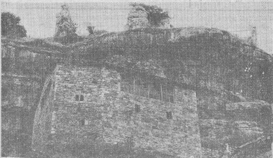
De modelo en su género, por el fondo y por la forma, se puede poner esta casa construida en el recinto encantado de Orbaneja del Castillo. El respeto al «medio» exige estos sacrificios y mimos, aunque sea excavando en roca. — (Foto J. L. Alonso).
