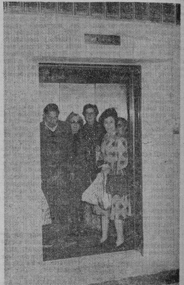
Se ha instalado un ascensor de servicio público en el Mercado de Abastos de la Zona Norte y ya ha empezado a funcionar. — (Foto FEDE)
